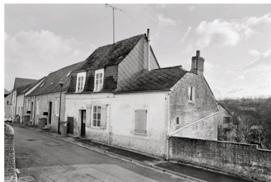
Vue de la façade sur rue. Phot. Pierre-Yves Brest IVR22_19990207081Z
