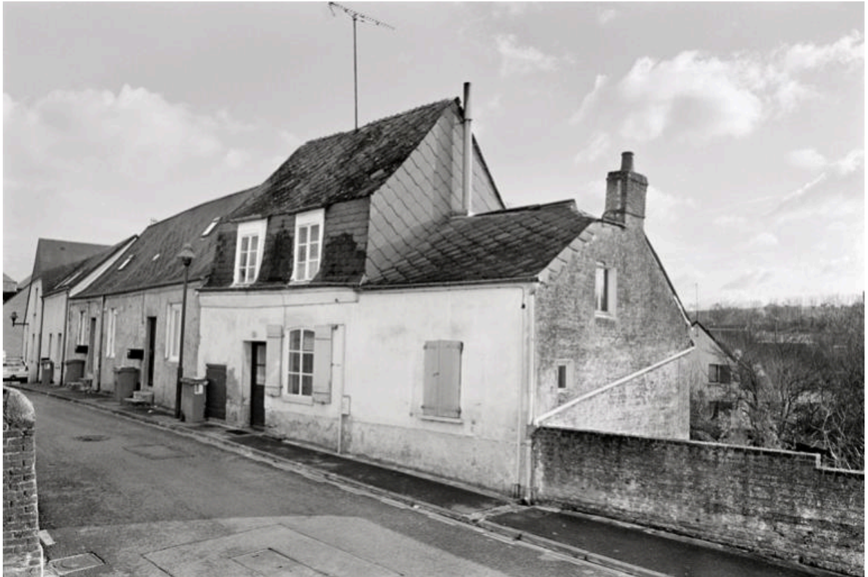
Vue de la façade sur rue.
