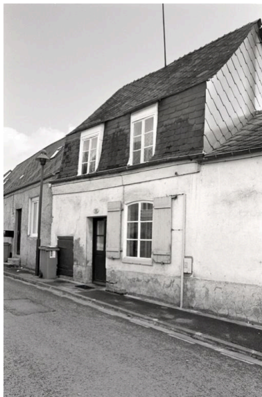
Vue de la façade sur rue. Phot. Pierre-Yves Brest IVR22_19990207082Z
