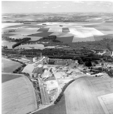
Vue aérienne, flanc sud-ouest. Phot. Phot'R IVR22_19888001314P
