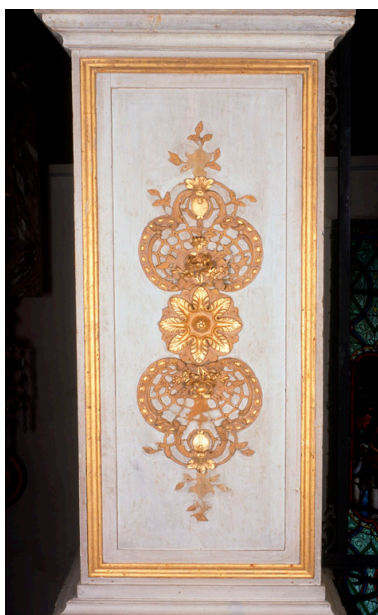
Détail d'un pilier en bois doré peint et doré à l'entrée de l'abside. Phot. Irwin Leullier IVR22_19998001033ZA
