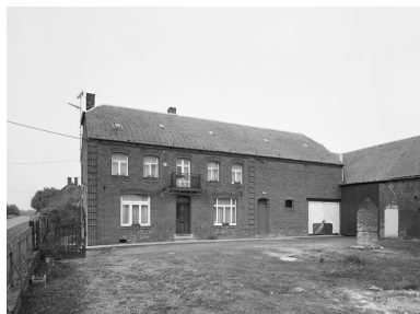
Logis et étable attenante. Phot. Thierry Lefébure IVR22_19930200524V
