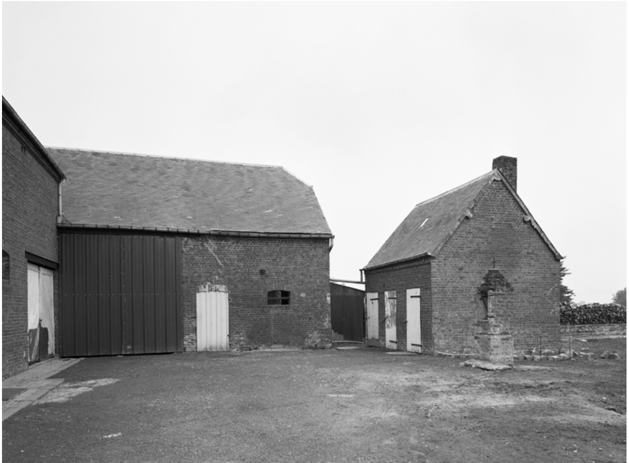
Bâtiments agricoles (grange et étables).
