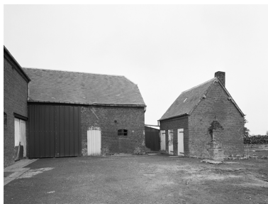
Bâtiments agricoles (grange et étables). Phot. Thierry Lefébure IVR22_19930200523V
