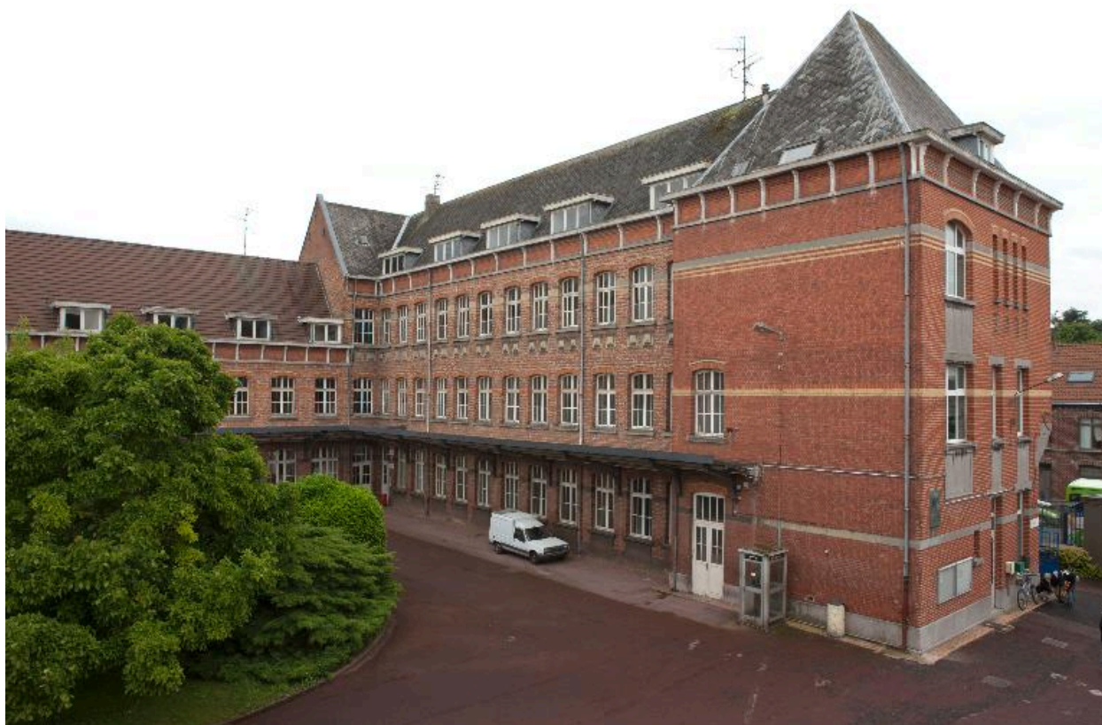
Une des deux ailes abritant des salles de classe construites pendant l'Entre-Deux-Guerres ; l'aile est, élévation postérieure.
