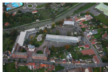
Vue aérienne du lycée, photographie sans date. IVR31_20145908031NUCA
