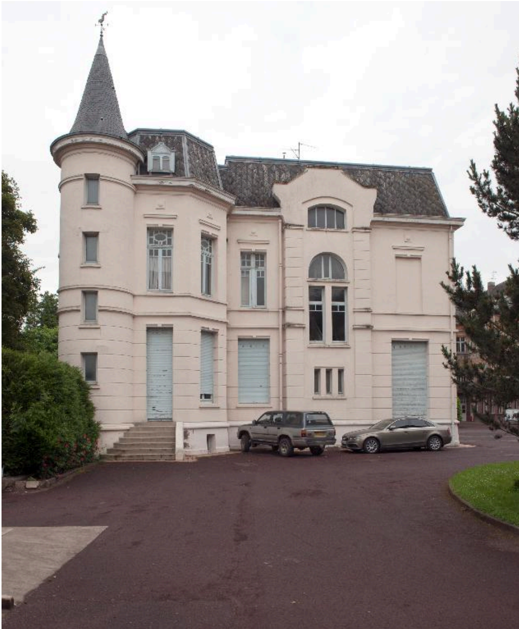
L'ancienne maison ayant abrité le logement du proviseur, vue de face.
