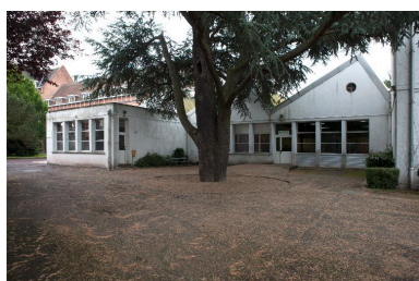
Les ateliers. Phot. Pierre Thibaut IVR31_20125901900NUCA
