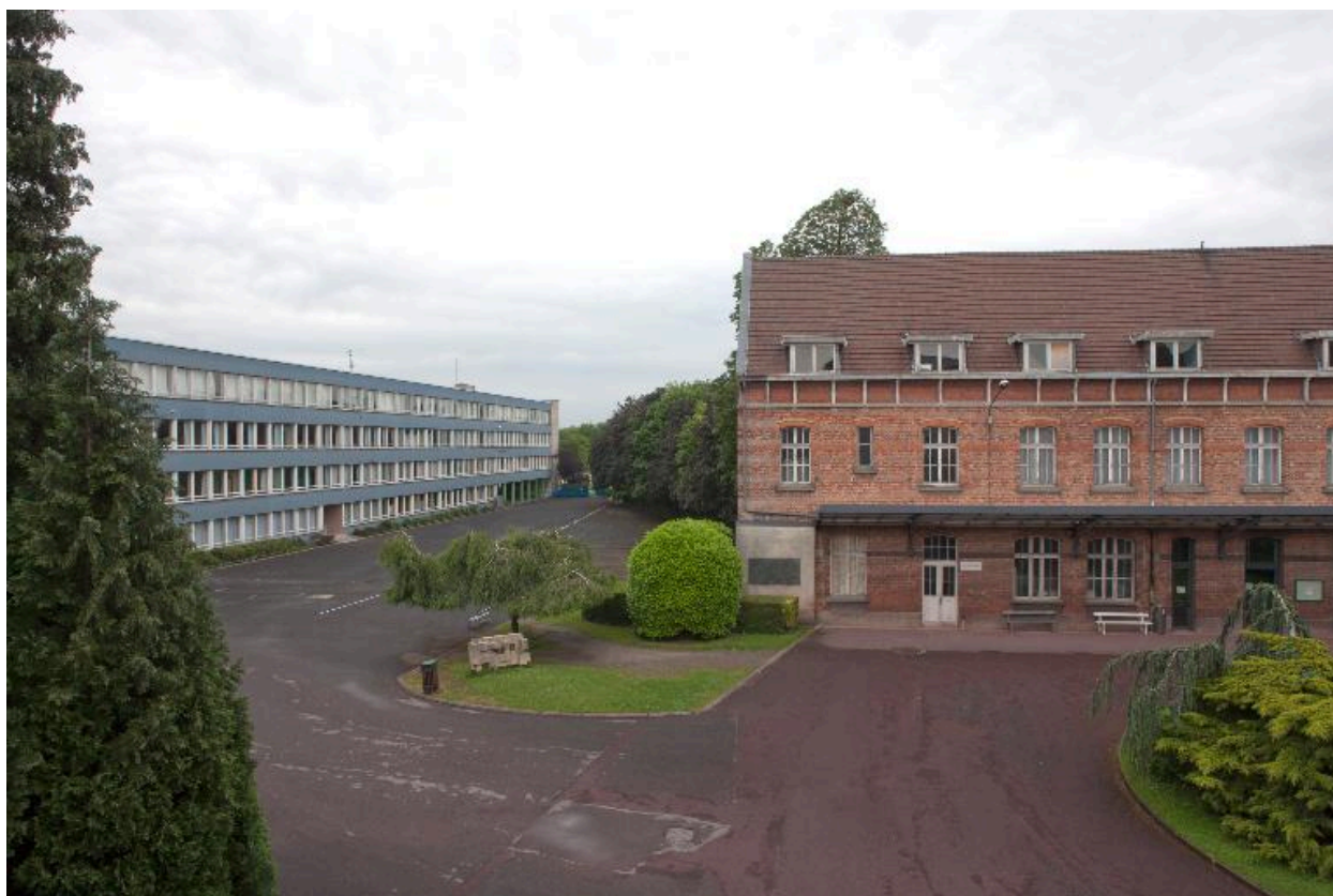
Vue générale d'une des ailes construite pendant l'Entre-Deux-Guerres et externat construit en 1968.
