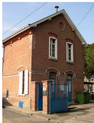
Amiens. La conciergerie du cimetière de Montières. Phot. Isabelle Barbedor IVR22_20078010395NUCA
