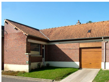
Garage et atelier. Phot. Frédéric Fournis IVR22_20118001130NUCA
