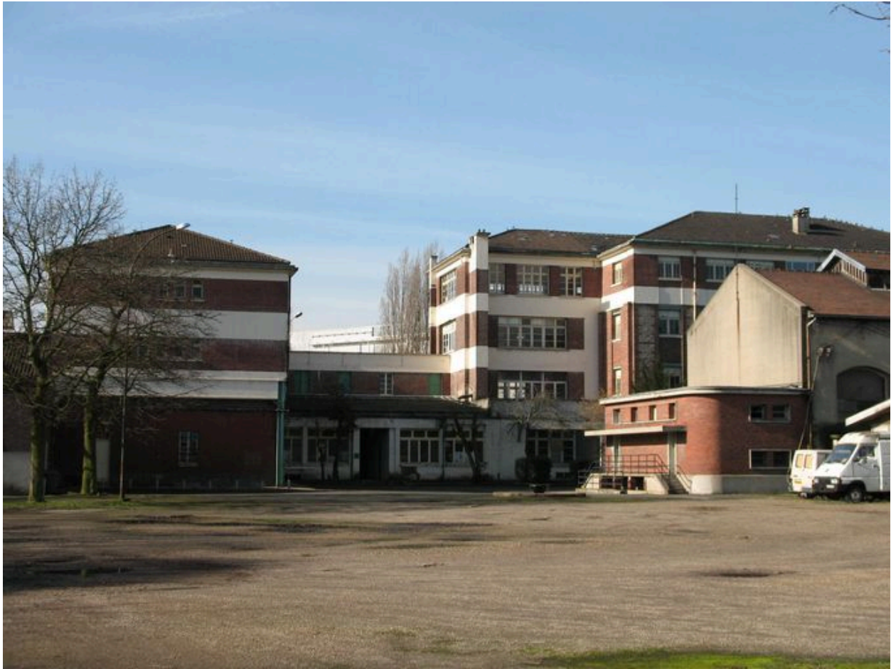
Vue générale des bâtiments de l'ancienne usine électrique depuis la cour.
