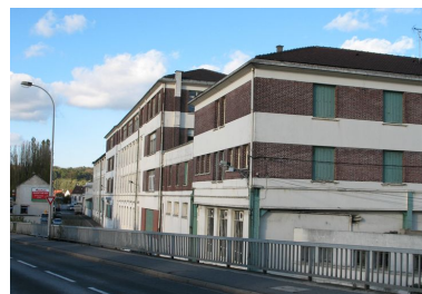
Le front bâti sur l'impasse de Gournay vu vers le nord-ouest Phot. Clarisse Lorieux IVR22_20066005034NUCA
