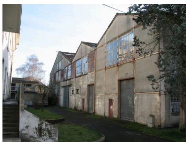
Les trois halles vue vers l'est. Phot. Clarisse Lorieux IVR22_20076005071NUCA
