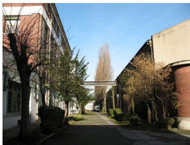
L'allée centrale délimitant les anciens bâtiments de production et de stockage. Phot. Clarisse Lorieux IVR22_20076005077NUCA
