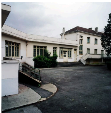
Vue des bureaux depuis la cour intérieure. Phot. Thierry Lefébure IVR22_20076000077XA
