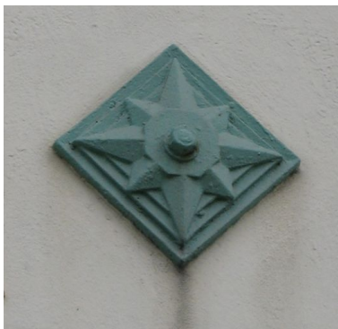
Fer d'ancrage de l'un des chaînages sur le mur de l'ancienne usine électrique. Phot. Clarisse Lorieux IVR22_20066005040NUCA
