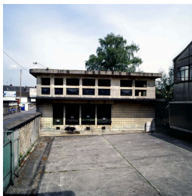
Transformateur électrique. Phot. Thierry Lefébure IVR22_20076000076XA
