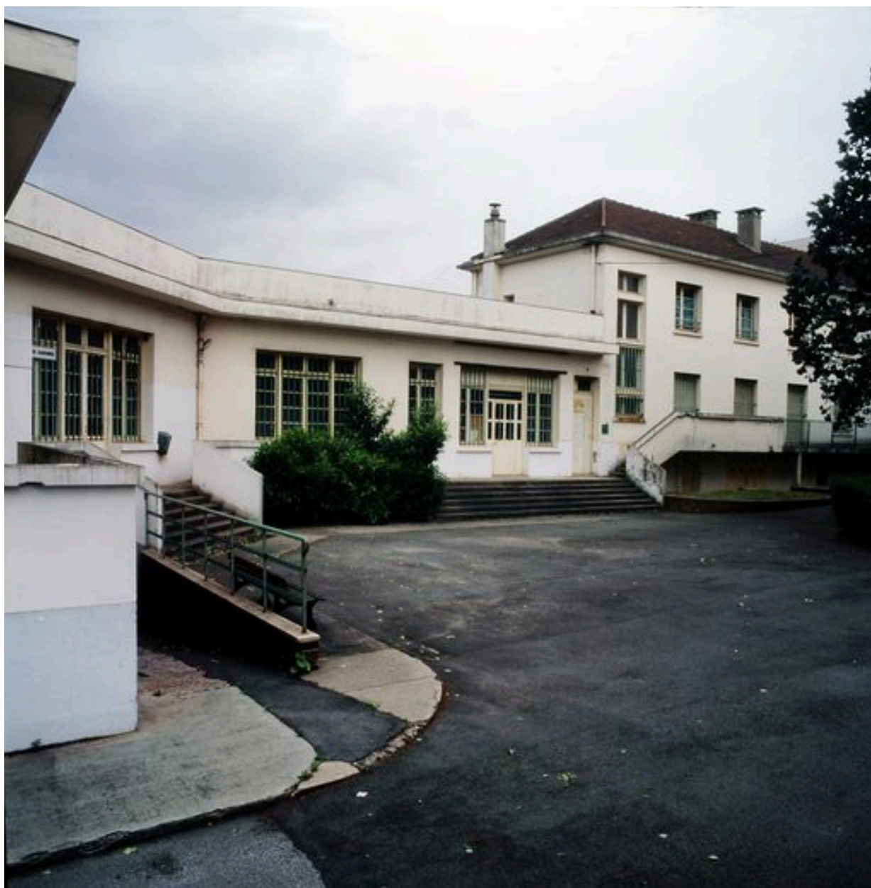
Vue des bureaux depuis la cour intérieure.
