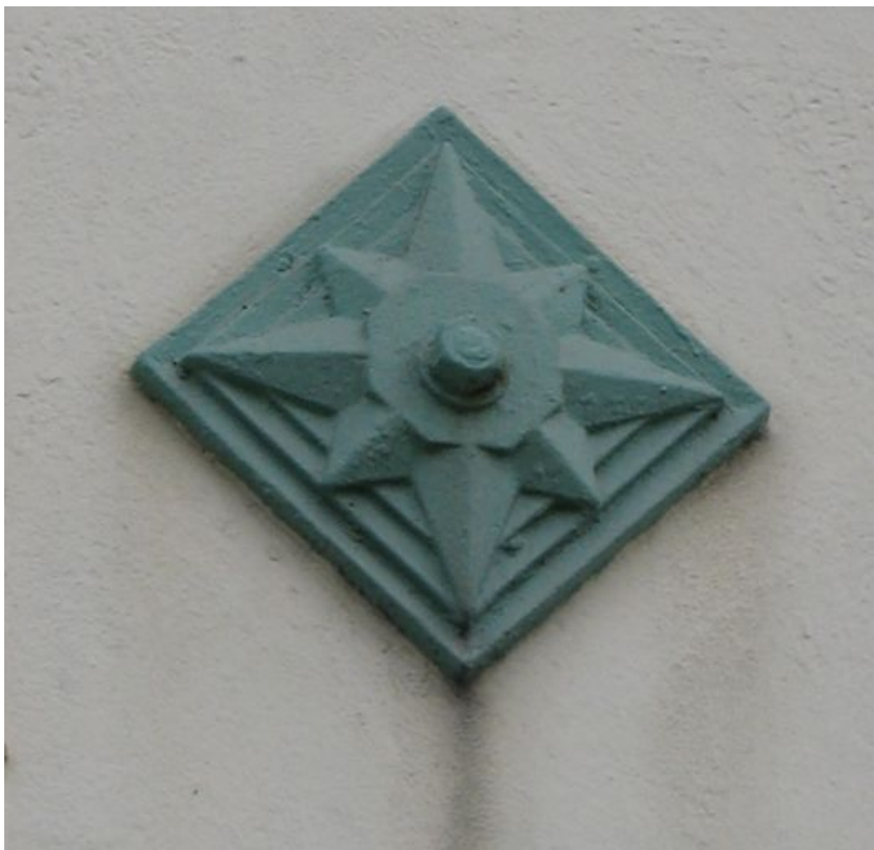
Fer d'ancrage de l'un des chaînages sur le mur de l'ancienne usine électrique.
