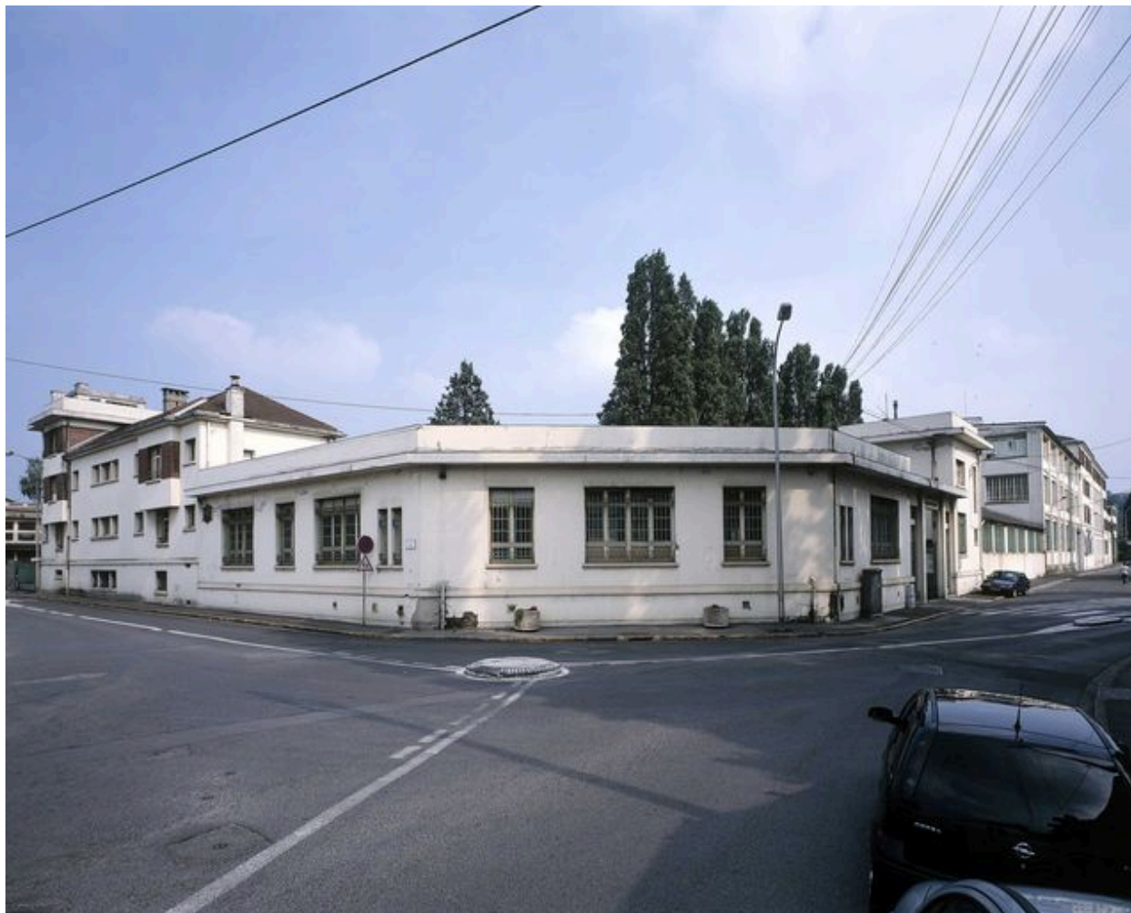
Bâtiment des bureaux formant l'angle de la rue des Usines et de la rue de Gournay.
