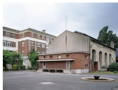
L'ancienne salle des machines transformée en salle de conférence à l'époque de l'installation du lycée. Phot. Thierry Lefébure IVR22_20076000069XA
