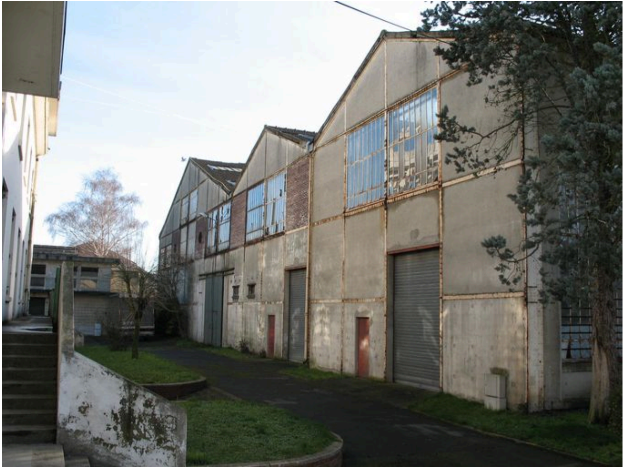
Les trois halles vue vers l'est.
