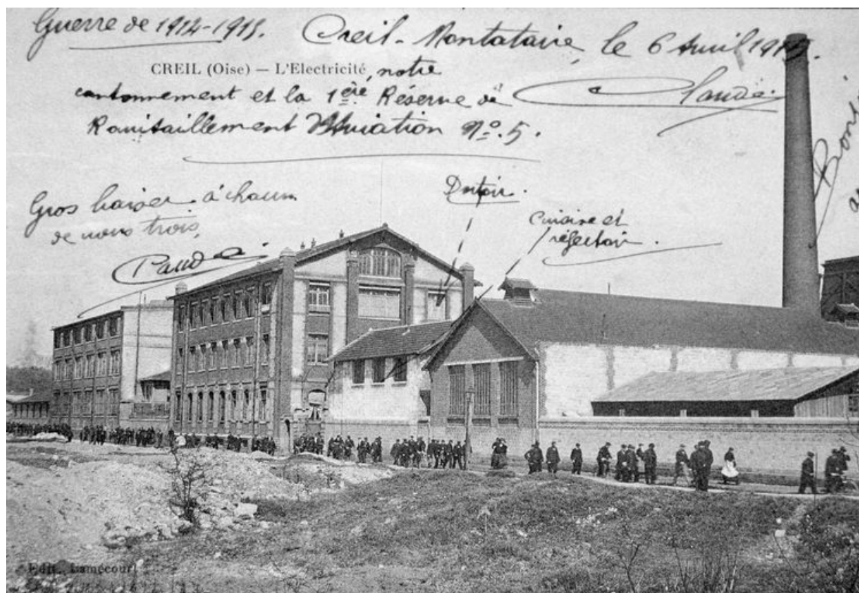
L'usine électrique en 1915 (AC Creil).
