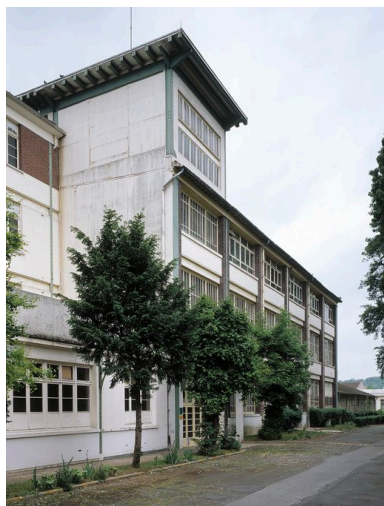
Tour d'escalier du lycée. Phot. Thierry Lefébure IVR22_20076000070XA
