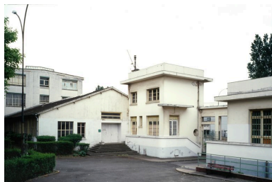
Vue de la conciergerie depuis la cour intérieure. Phot. Thierry Lefébure IVR22_20076000065XA
