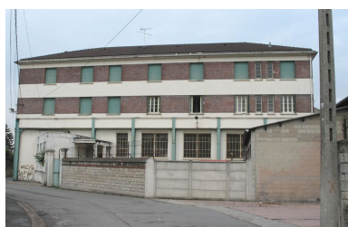
Pignon sud du lycée Gournay. Phot. Clarisse Lorieux IVR22_20066005035NUCA
