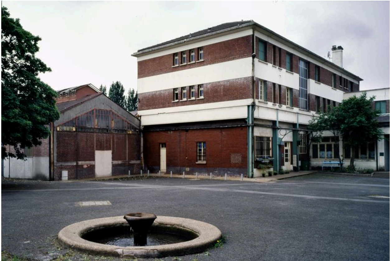
Ancien préau et bâtiment abritant la lingerie.
