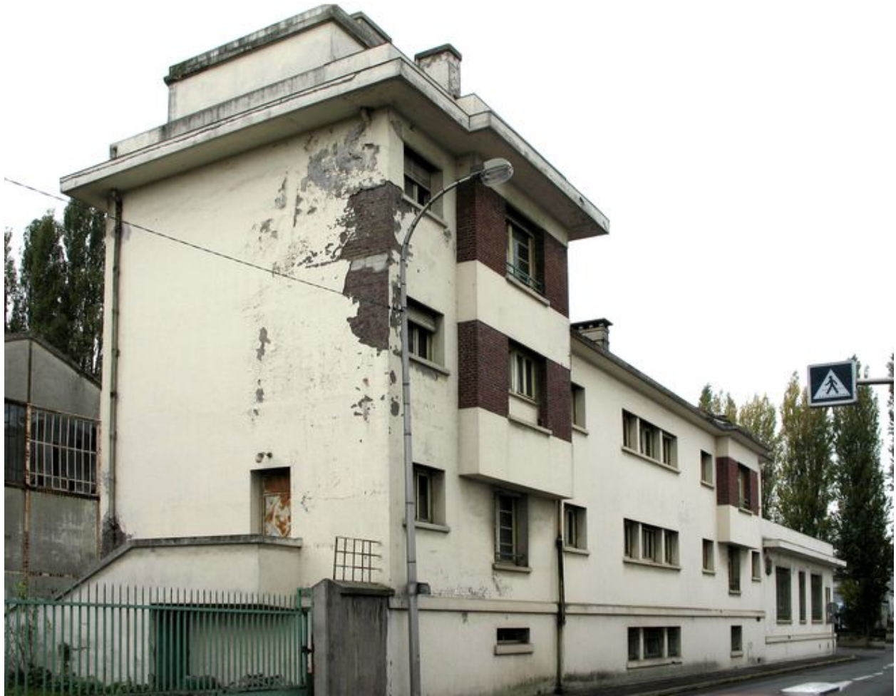
Bureaux et loge du concierge sur la rue des Usines.
