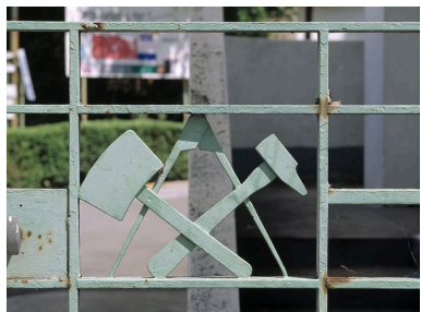
Détail du portail d'entrée : compas, marteau et masse. Phot. Thierry Lefébure IVR22_20076000033XA
