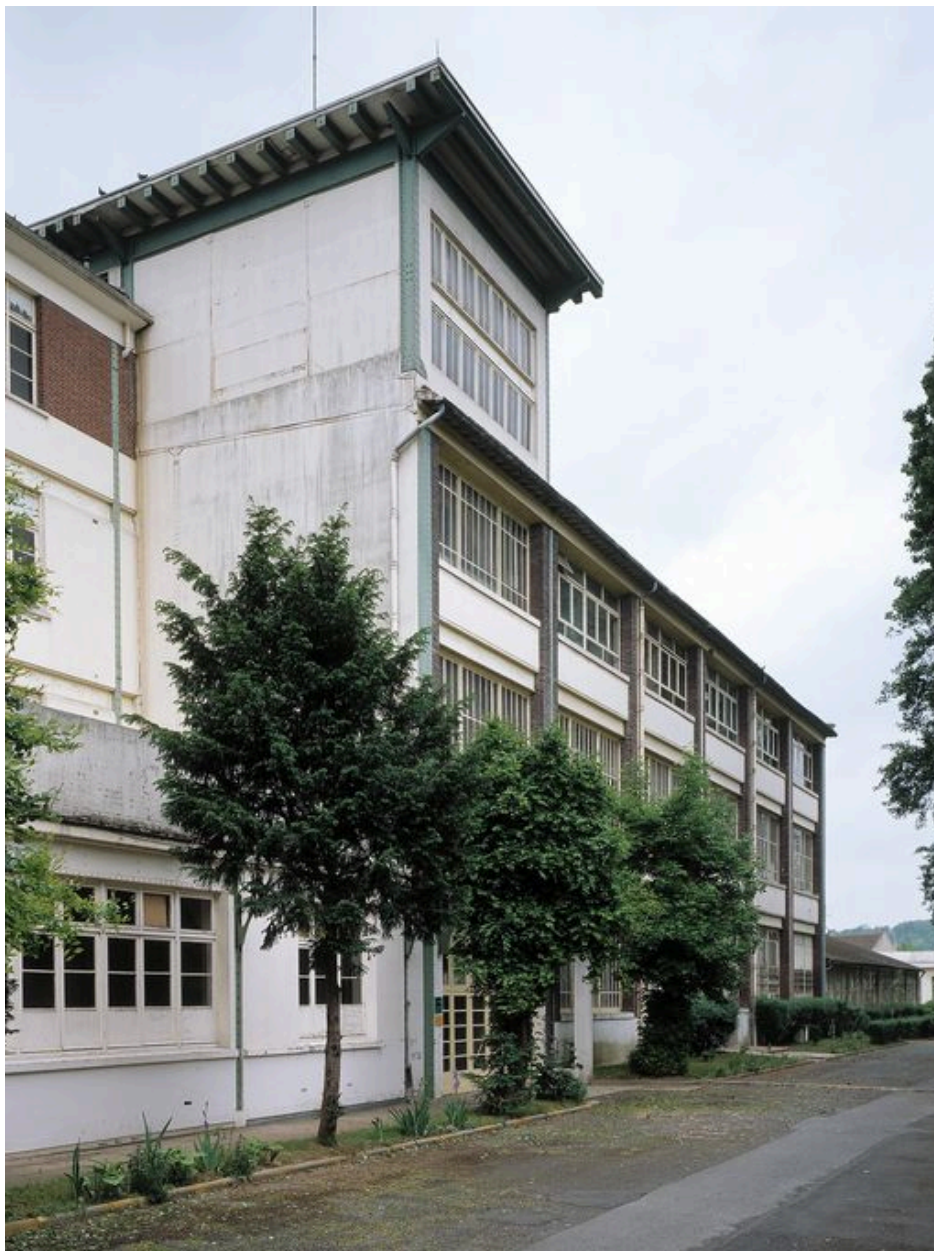
Tour d'escalier du lycée.
