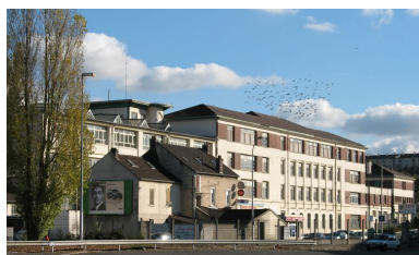
Front bâti sur l'impasse de Gournay de l'ancienne usine électrique transformée en lycée. Phot. Clarisse Lorieux IVR22_20066005033NUCA
