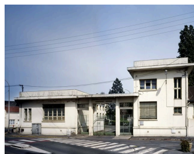
Portail d'entrée du lycée professionnel. Phot. Thierry Lefébure IVR22_20076000002VA
