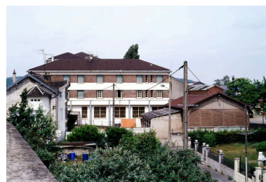
Vue du lycée Gournay depuis le pont Y. Au premier plan, les jardins et la cité ouvrière cheminote (détruits). Phot. Thierry Lefebure IVR22_20076000073XA
