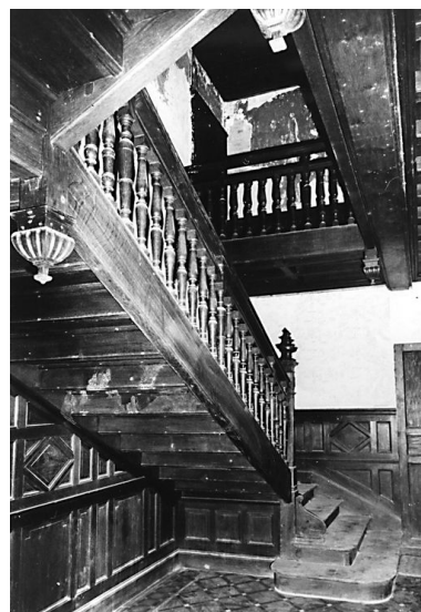
Escalier en retour avec jour (AP). Phot. Thierry Lefébure IVR22_20020200365XB
