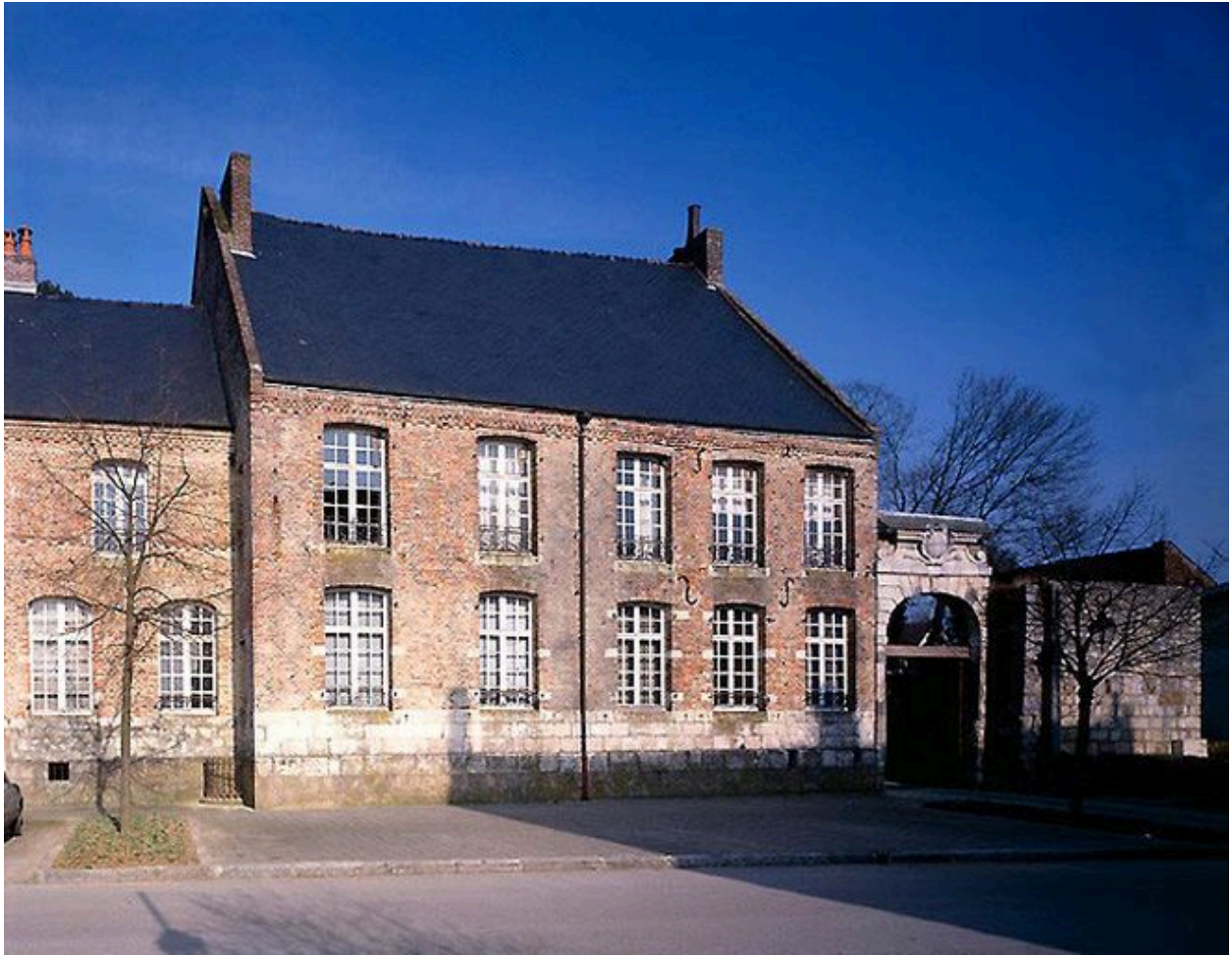
Vue générale sur rue.
