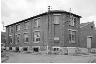
Atelier de fabrication, élévation antérieure. Phot. Benoît Dufournier IVR22_19888000248Z
