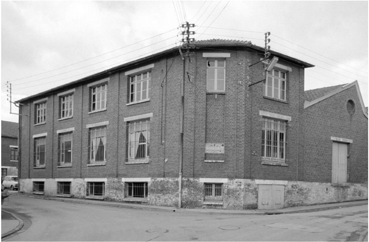
Atelier de fabrication, élévation antérieure.
