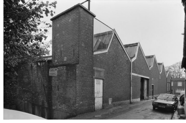
Les ateliers de fabrication et le transformateur, rue Paul-Baroux, en 1987. Phot. Benoît Dufournier IVR22_19878000407Z
