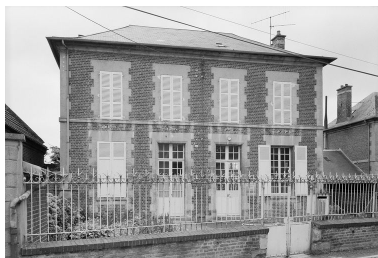
Elévation antérieure. Phot. Jean-Michel Perrin IVR22_19846000957X
