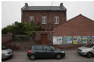
Vue générale. Phot. Pierre Thibaut IVR31_20125901762NUCA
