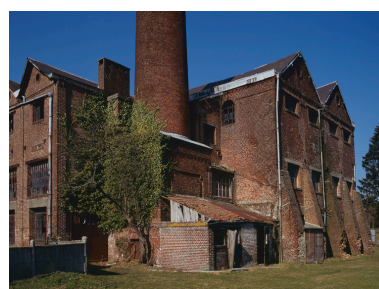
Vue sud de l'ancien bâtiment de la machine à vapeur avec la partie inférieure de la cheminée. Phot. Thierry Lefébure IVR22_19960200103XA
