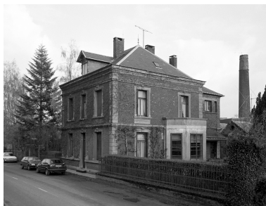
Vue générale du logement patronal. Phot. Thierry Lefébure IVR22_19960200870X
