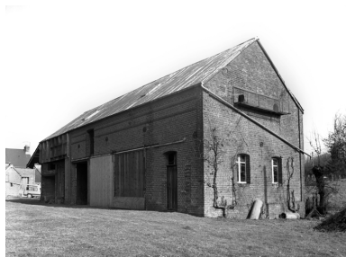
Vue des écuries et remises. Phot. Thierry Lefébure IVR22_19960200100X
