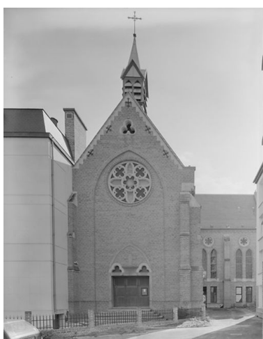
Façade occidentale de la chapelle.
