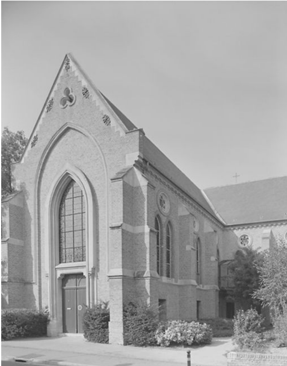
Façade sud de la chapelle.
