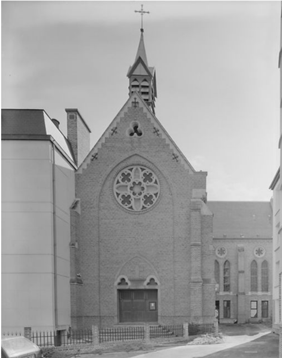
Façade occidentale de la chapelle.
