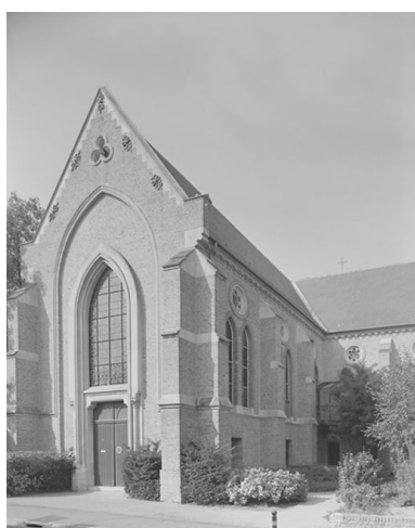
Façade sud de la chapelle.
