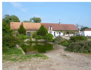
Vue du logis à l'est. Phot. Inès Guérin IVR22_20078005850NUCA
