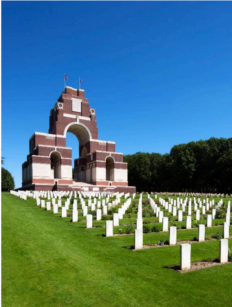
Vue du monument, depuis le nord-ouest.
