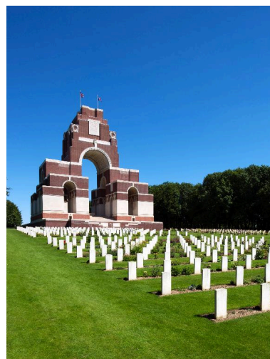
Vue du monument, depuis le nord-ouest. Phot. Marie-Laure Monnehay-Vulliet IVR22_20128000964NUC2A
