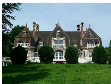
Craonelle. Le château reconstruit sur les plans de l'architecte Boessé (1926-1927). Phot. Inès Guérin IVR22_20030202631NUCA
