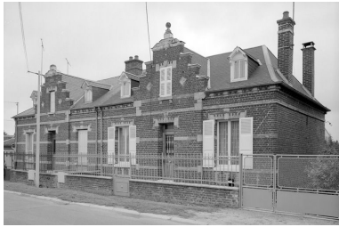
Pont-L'Evêque. Maison à deux unités d'habitation. Phot. Jean-Michel Perrin IVR22_19856000948X
