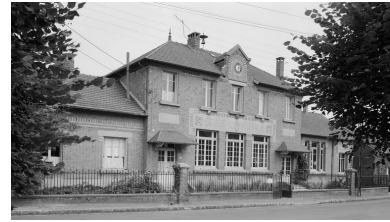
Varesne (Oise). La mairie et école reconstruite sur les plans de l'architecte Etienne Gaston (1924). Phot. Jean-Michel Perrin IVR22_19846001100X
