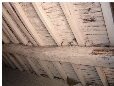
Vue du plafond d'une deuxième étable ici fait en torchis et non plus en plancher.
