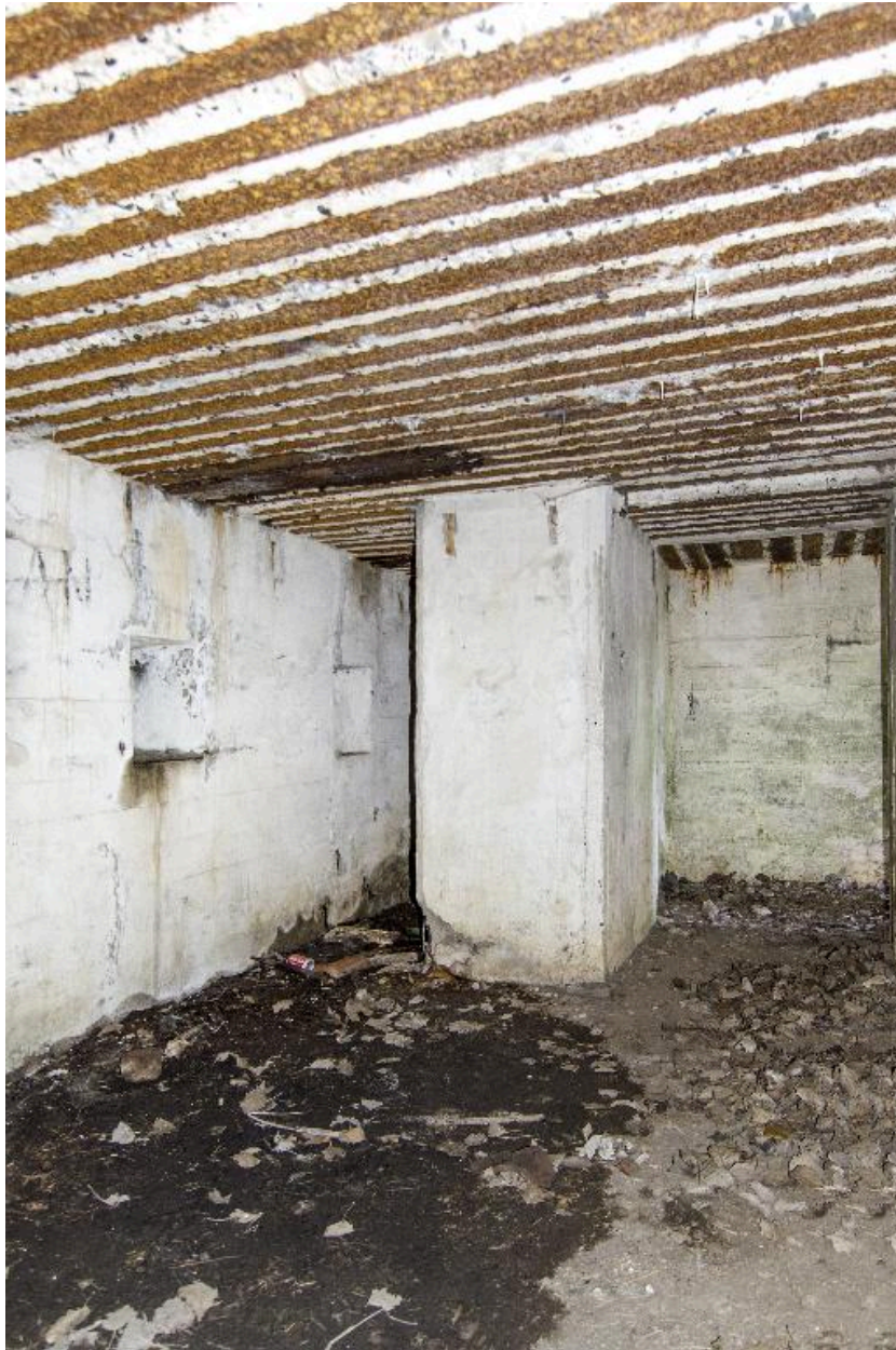
Vue intérieure (au grand angle). A gauche, l'accès à la coursière de tir sud, à droite la sortie est.
