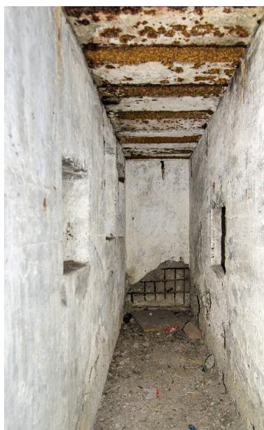
Vue intérieure (au grand angle) de la coursière de tir flanquant l'entrée ouest. IVR32_20165901127NUCA
