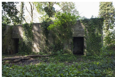
Elévation sud, entrées Phot. Jean-Marc Ramette IVR31_20145904865NUCA
