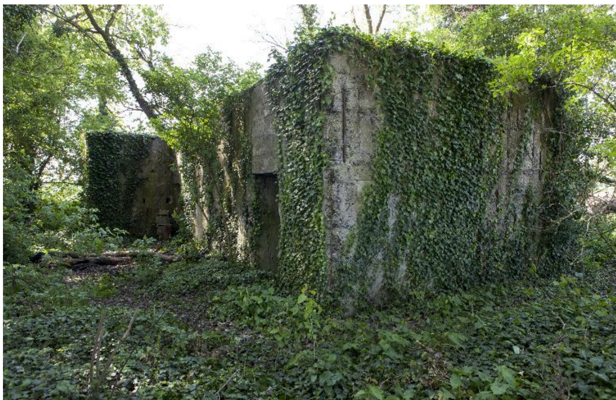
Vue de trois-quarts vers le nord
