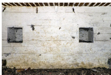
Vue intérieure (au grans angle). Niches dans le mur sud Phot. Jean-Marc Ramette IVR32_20165901125NUCA
