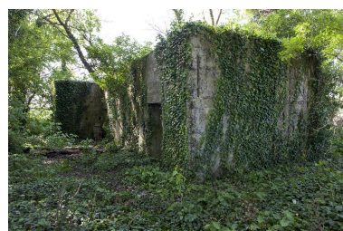
Vue de trois-quarts vers le nord Phot. Jean-Marc Ramette IVR31_20145904863NUCA
