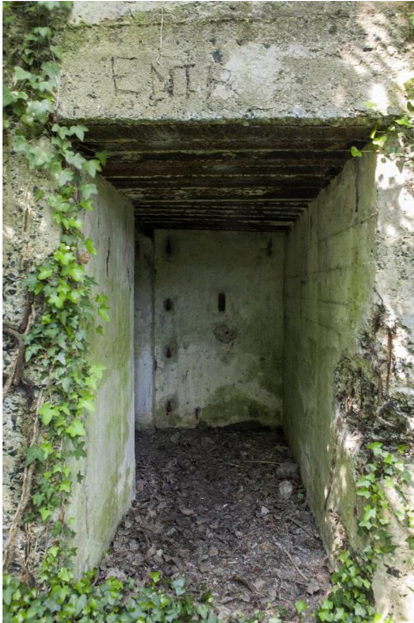
Entrée est. Au fond, on aperçoit le creneau de fusillade flanquant l'entrée.
