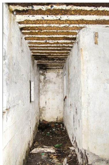
Vue intérieure (au grand angle) de la coursière de tir flanquant l'entrée est. Phot. Jean-Marc Ramette IVR32_20165901126NUCA
