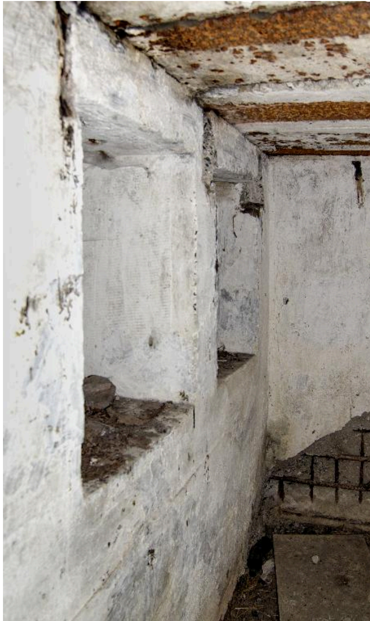
Vue intérieure (au grand angle) de la coursière de tir flanquant l'entrée est. Détail des coursières de tir
