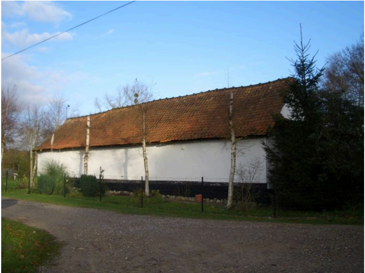
Vue postérieure des dépendances.
