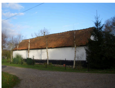
Vue postérieure des dépendances.
