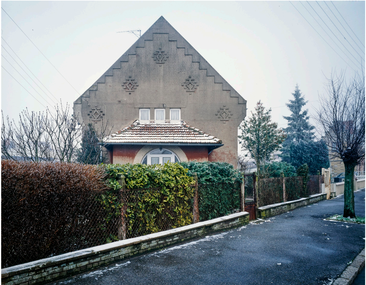
Maisons jumelées, pignon sud sis au 90 avenue du Général-Leclerc.
