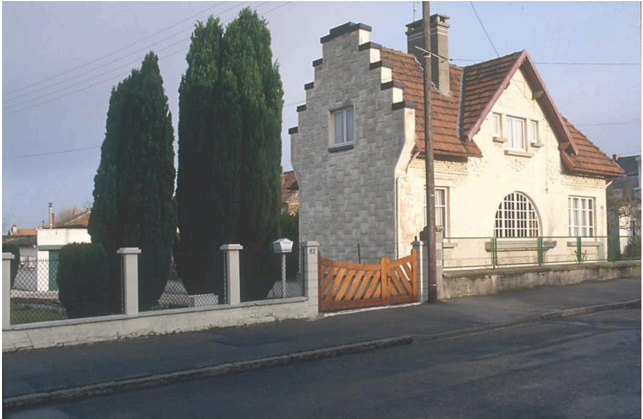
Module d'habitation, maison située au 80 avenue du Général-Leclerc, élévation antérieure prise de trois quarts.
