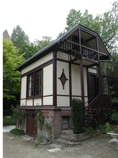
Communs de la villa La Tour. Phot. Elisabeth Justome IVR22_20048001428NUCA
