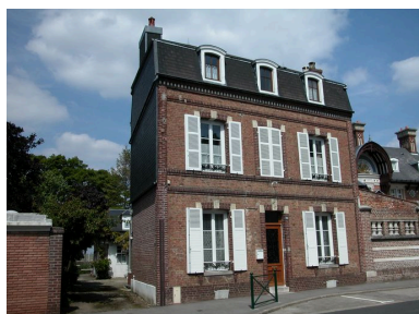
Le type de la maison de ville (quai de Romerel).
