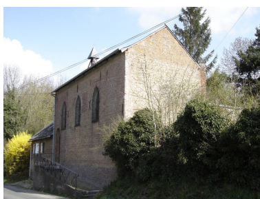
Vue générale depuis la rue. Phot. Inès Guérin IVR22_20058005653NUCA
