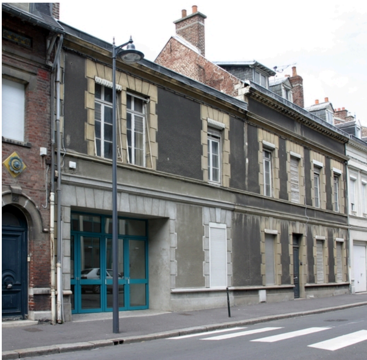
Vue des bureaux, rue Antoine-Lecuyer.
