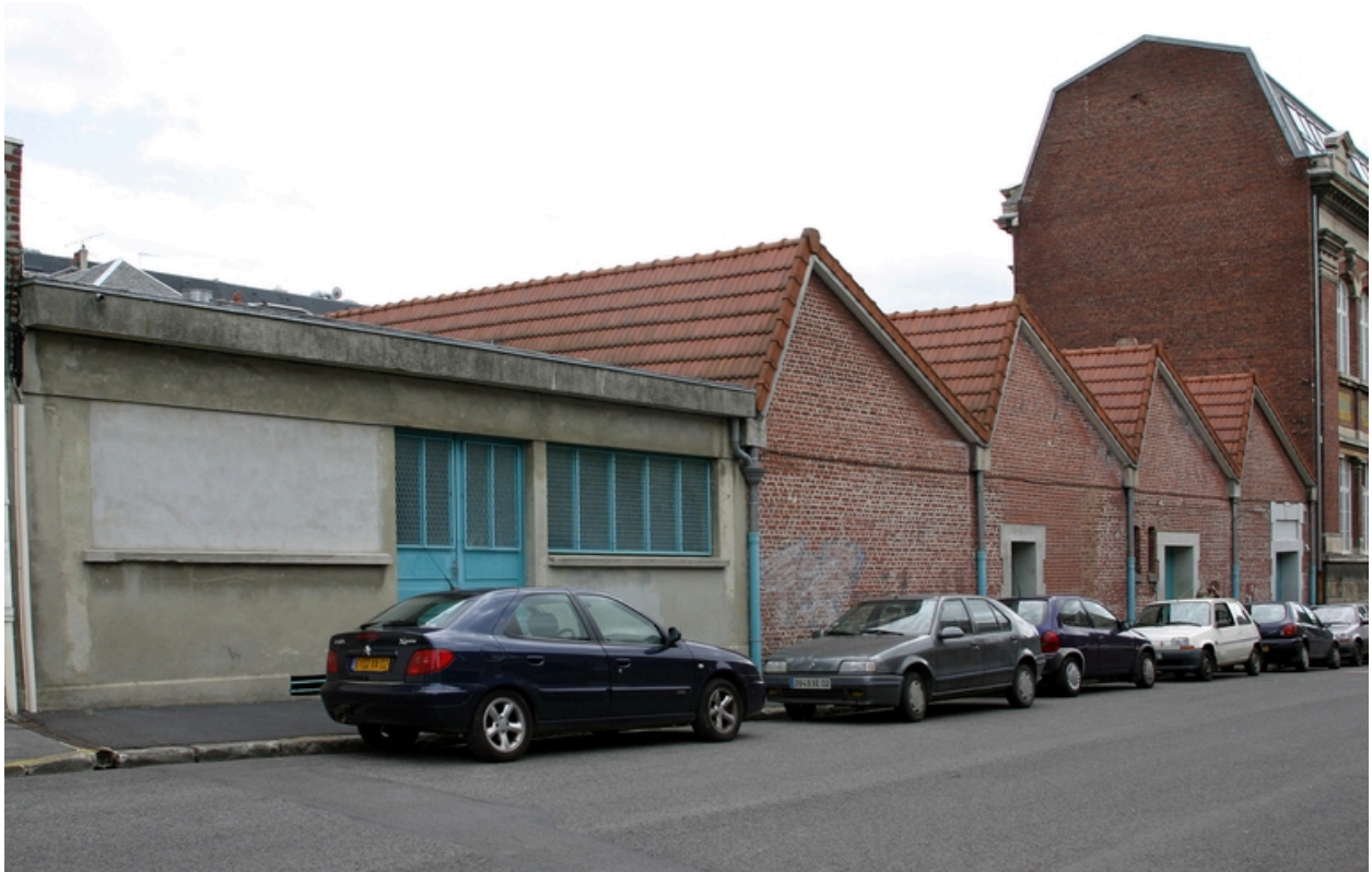
Vue des ateliers, rue Emmeré.
