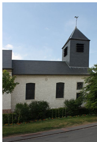
Vue du mur sud du chœur. Phot. Bertrand Fournier IVR22_20098005817NUCA
