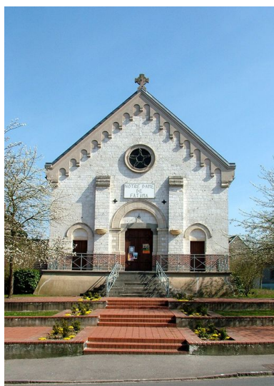
Façade occidentale. Phot. Frédéric Fournis IVR22_20118001094NUCA
