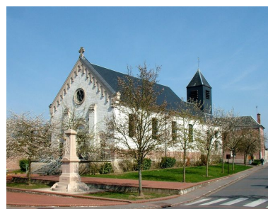
Vue de trois-quarts. Phot. Frédéric Fournis IVR22_20118001093NUCA
