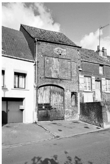
Vue de la façade sur rue. Phot. Pierre-Yves Brest IVR22_19990207079Z
