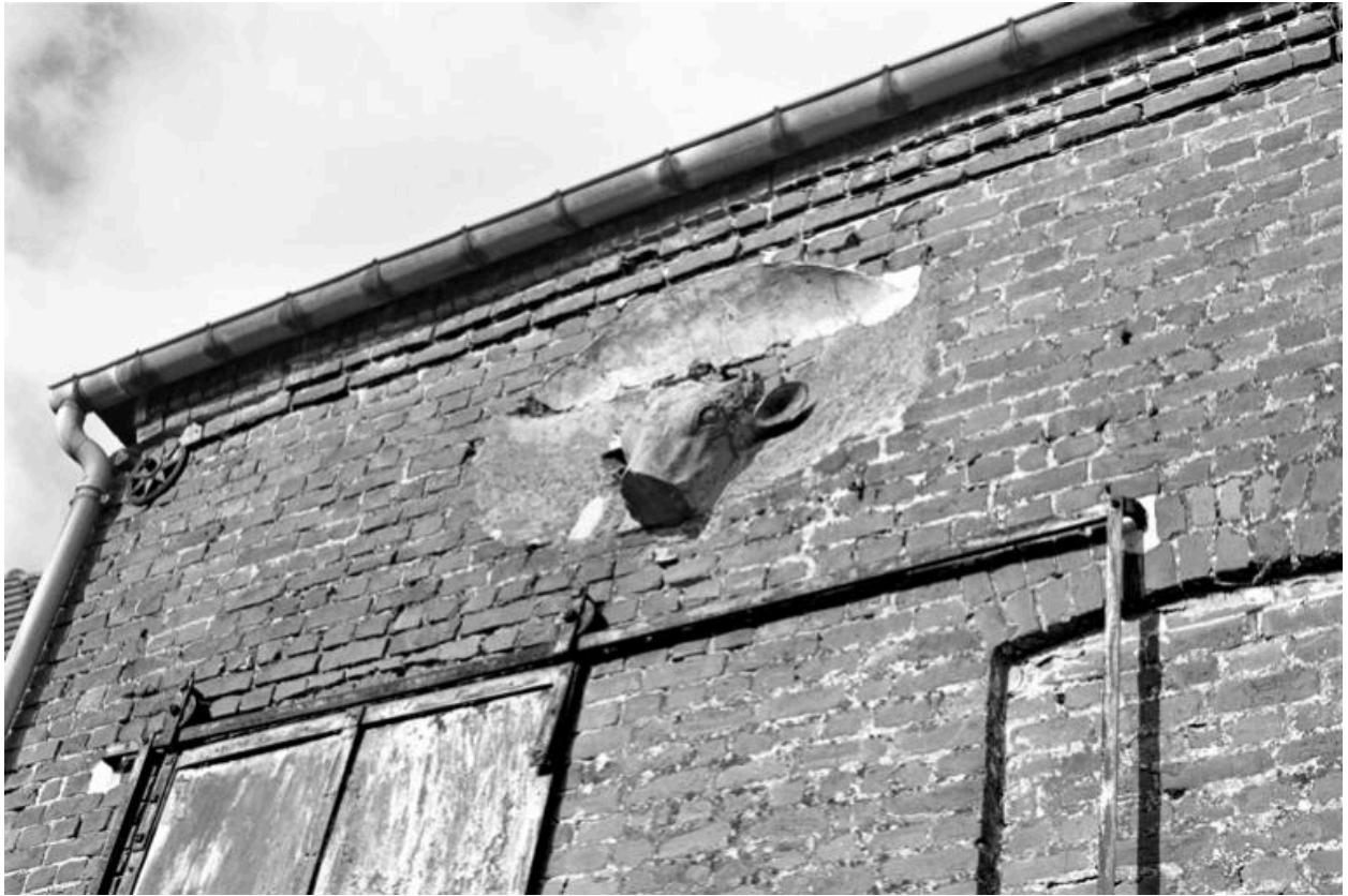
Détail de la tête de boeuf sculptée et insérée dans le mur de la façade sur rue.
