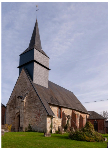
Église paroissiale Saint-Pierre, vue depuis le nord-ouest.
