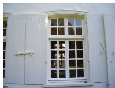
Vue détaillée des contrevents. Phot. Inès Guérin IVR22_20068005538NUCA
