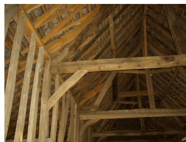
Vue partielle de sa charpente. Phot. Inès Guérin IVR22_20068005542NUCA
