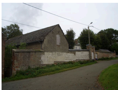
Vue générale depuis la rue du presbytère. Phot. Inès Guérin IVR22_20068005526NUCA
