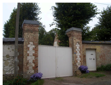
Vue de l'entrée sud. Phot. Inès Guérin IVR22_20068005530NUCA
