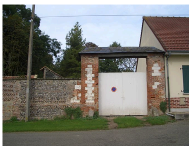
Vue de l'entrée située au nord. Phot. Inès Guérin IVR22_20068005529NUCA
