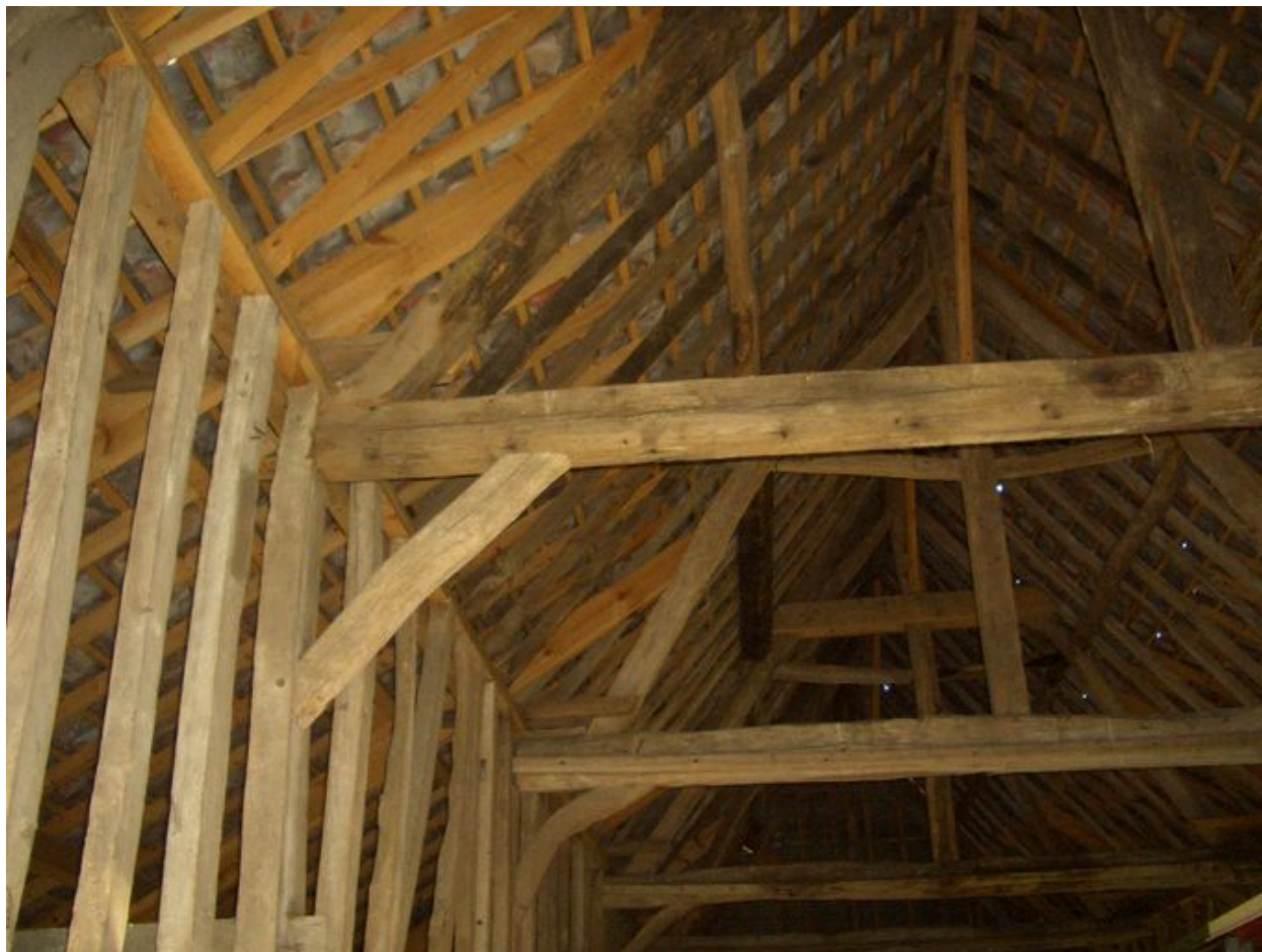
Vue partielle de sa charpente.
