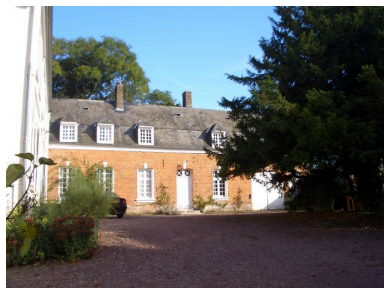
Vue des dépendances du 18e siècle au nord de la cour. Phot. Inès Guérin IVR22_20068005531NUCA
