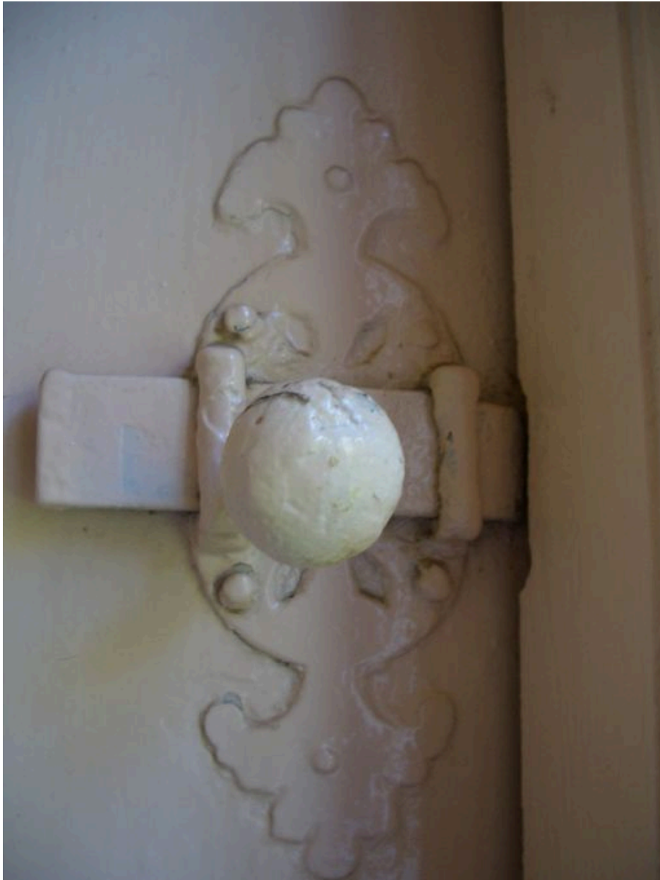
Vue détaillée d'un loquet du logis.
