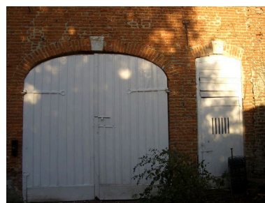
Vue détaillée des portes de la remise dans les dépendances 18e siècle. Phot. Inès Guérin IVR22_20068005533NUCA
