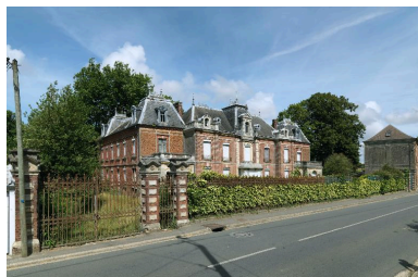
Vue générale. Phot. Thierry Lefébure IVR22_20128000812NUC2A
