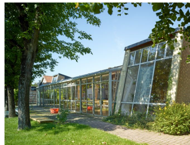
Élévation de trois quart, côté sud. Phot. Pierre Thibaut IVR31_20156200214NUCA
