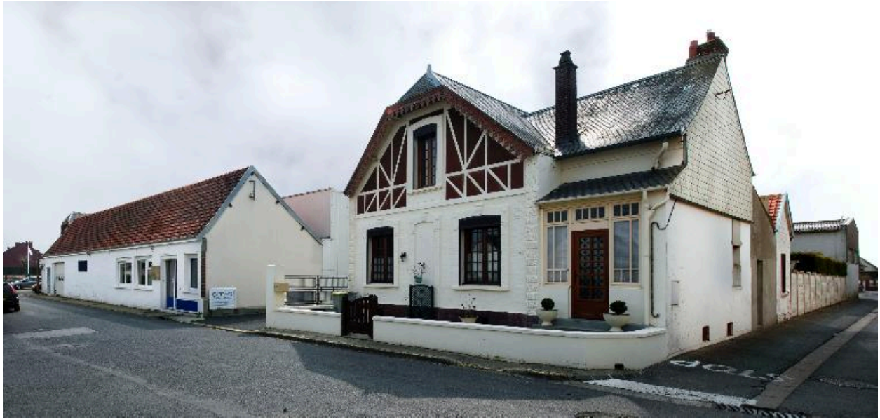
Bureau et atelier de fabrication, depuis la rue Emile-Zola.
