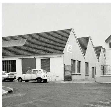
Vue partielle des ateliers de fabrication. Phot. Francis Dubuc IVR22_199080001872Z
