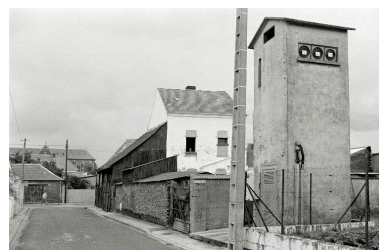
Élévation sud des anciens ateliers, 14 rue Voltaire. Phot. Francis Dubuc IVR22_19908000144Z
