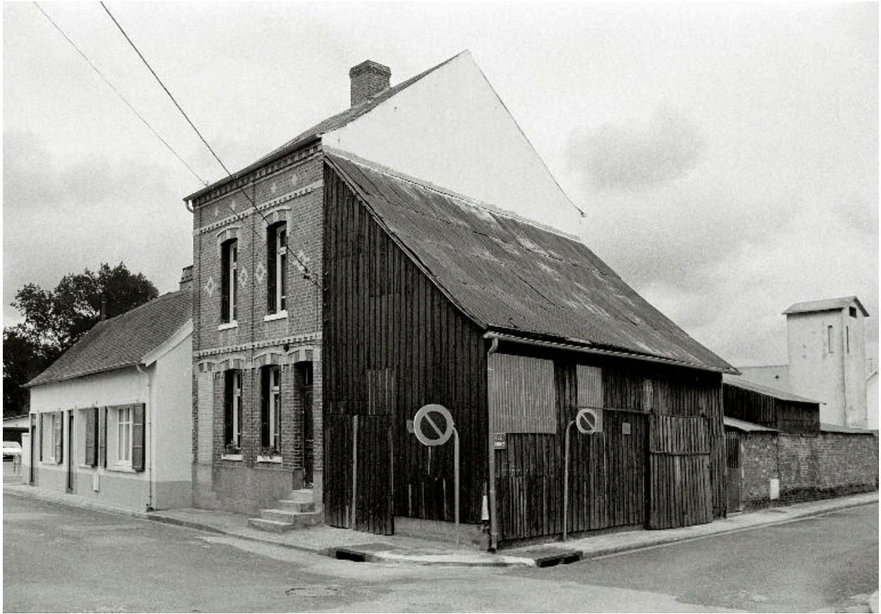
Vue de trois-quarts des anciens ateliers, 14 rue Voltaire.
