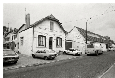
Bureau et atelier de fabrication. Phot. Francis Dubuc IVR22_19908000141Z
