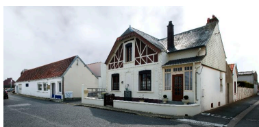
Bureau et atelier de fabrication, depuis la rue Emile-Zola. Phot. Thierry Lefébure IVR22_20138000030NUC2AQ
