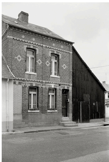
Anciens ateliers, 14 rue Voltaire. Phot. Francis Dubuc IVR22_19908000142Z
