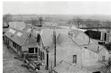
Vue cavalière de l'usine et des logements patronaux, vers 1950 (coll. part.). Phot. Francis Dubuc (reproduction) IVR22_19908000129ZB
