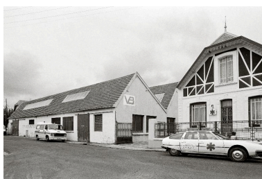
Bureau et atelier de fabrication. Phot. Francis Dubuc IVR22_19908000140Z
