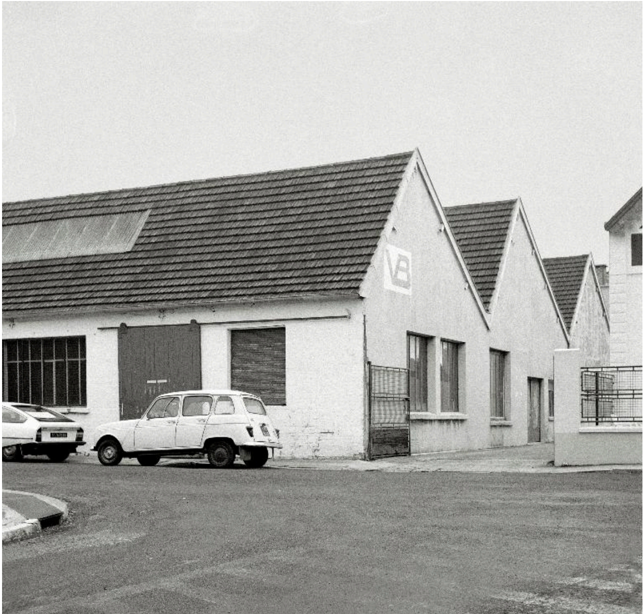
Vue partielle des ateliers de fabrication.
