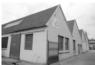
Atelier de fabrication, vue partielle flanc nord ouest. Phot. Francis Dubuc IVR22_19908000139Z
