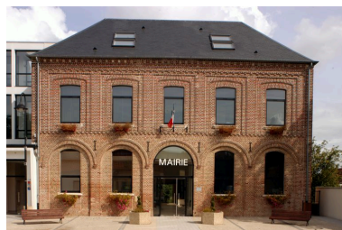
Vue de la façade sud.
