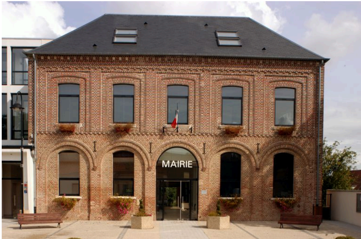
Vue de la façade sud.
