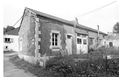
Ancienne laiterie transformée en porcherie. Phot. Xavier-Philippe Guiochon IVR22_19980202995Z
