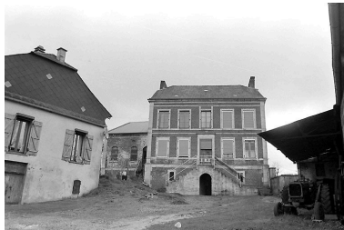
Vue générale. Phot. Xavier-Philippe Guiochon IVR22_19980200803Z
