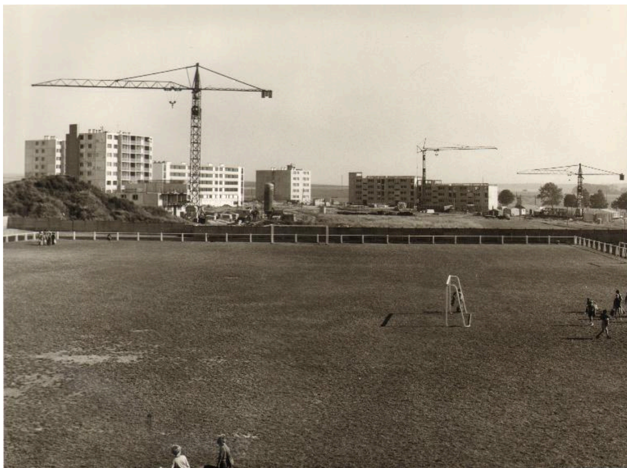
ZAC sud-est en construction depuis le centre aéré Robert Viarre en 1973 (AC Abbeville ; PHNB 1351).
