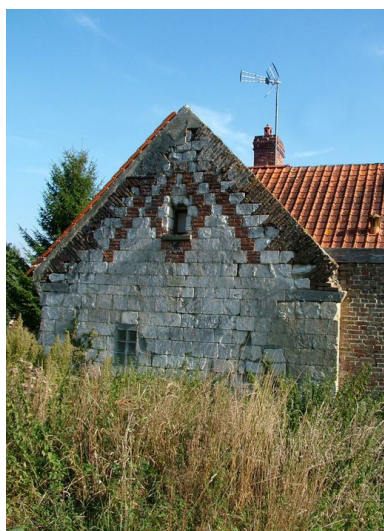
Pignon ouest du logis. Phot. Frédéric Fournis IVR22_20098005451NUCA
