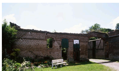
Grange et passage charretier. Phot. Marie-Laure Monnehay-Vulliet IVR22_20098000198XA
