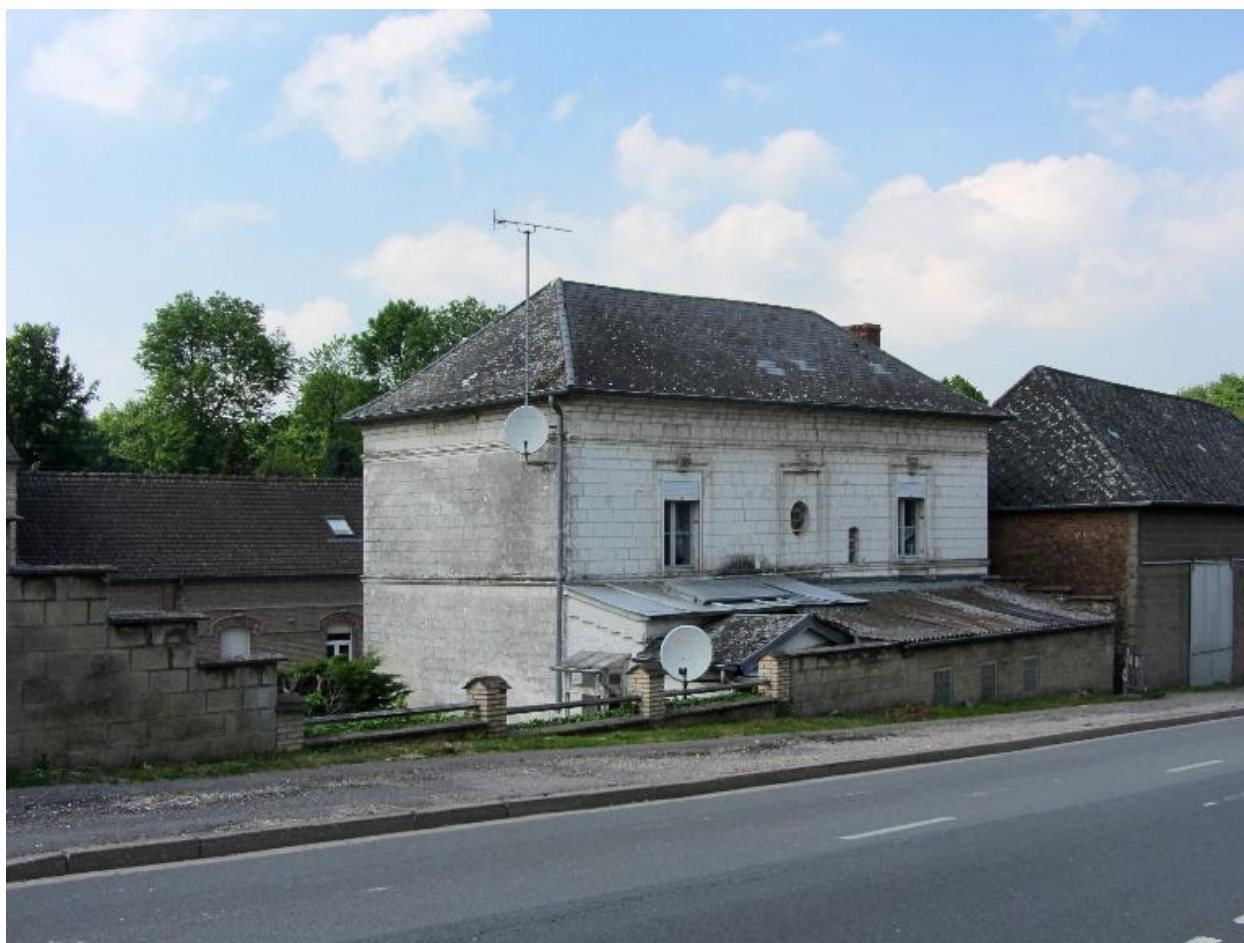
Façade postérieure donnant sur la route Nationale.
