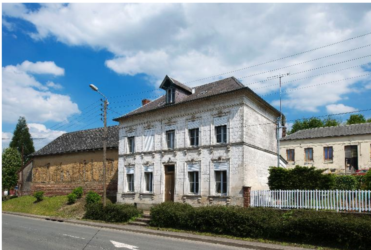
Vue d'ensemble sur rue.
