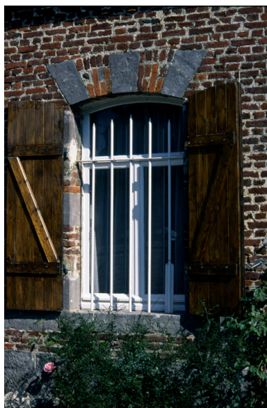
Détail d'une fenêtre. Phot. Christiane Riboulleau IVR22_19950203084ZA
