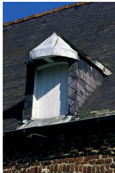
Détail de la lucarne qui surmonte la porte d'entrée. Phot. Christiane Riboulleau IVR22_19950203083ZA
