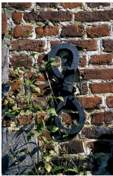
Ancre en fer forgé, en forme de 8, contribuant à inscrire la date de construction (1788) sur la façade. Phot. Christiane Riboulleau IVR22_19950203086ZA
