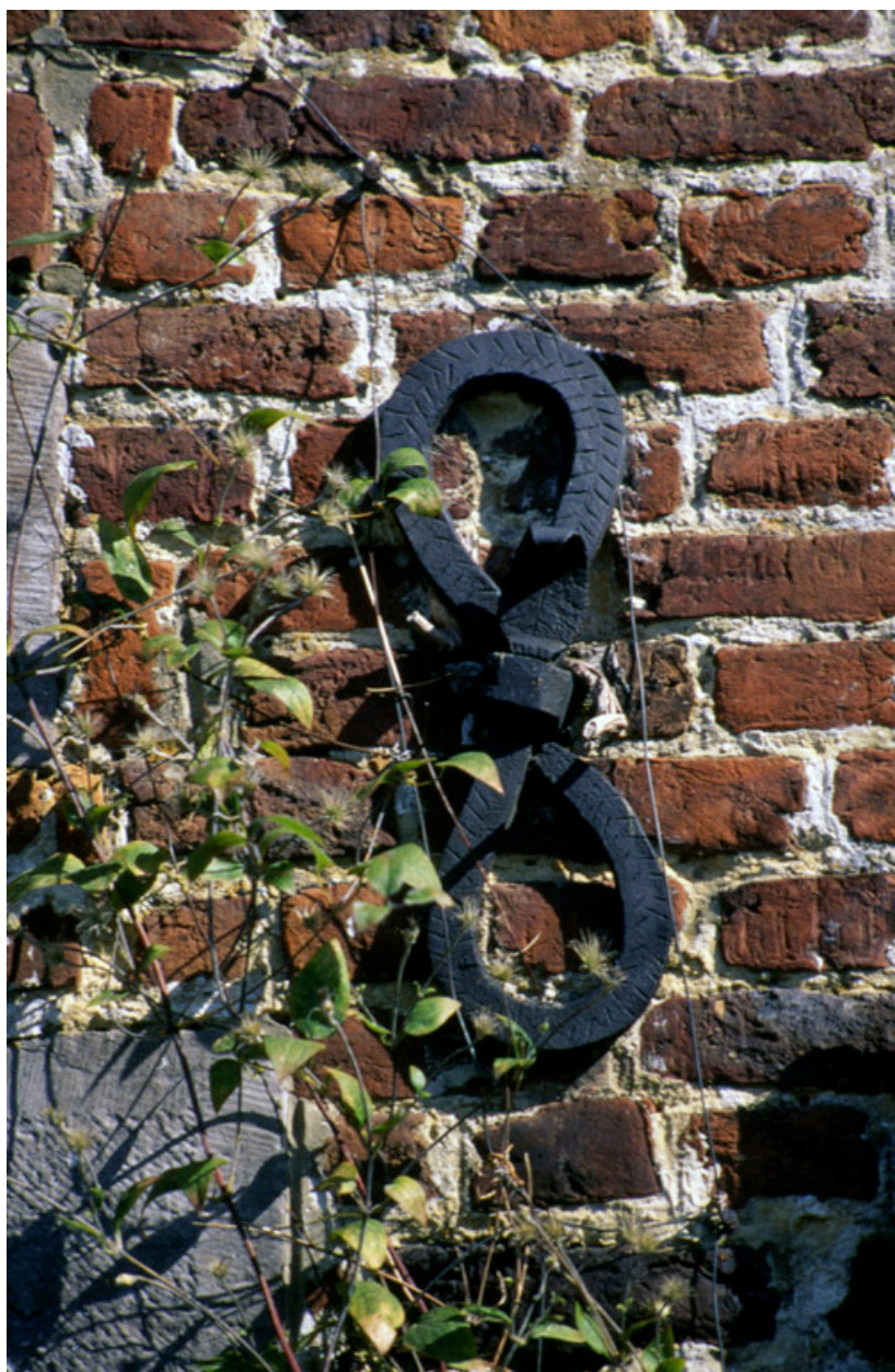
Ancre en fer forgé, en forme de 8, contribuant à inscrire la date de construction (1788) sur la façade.
