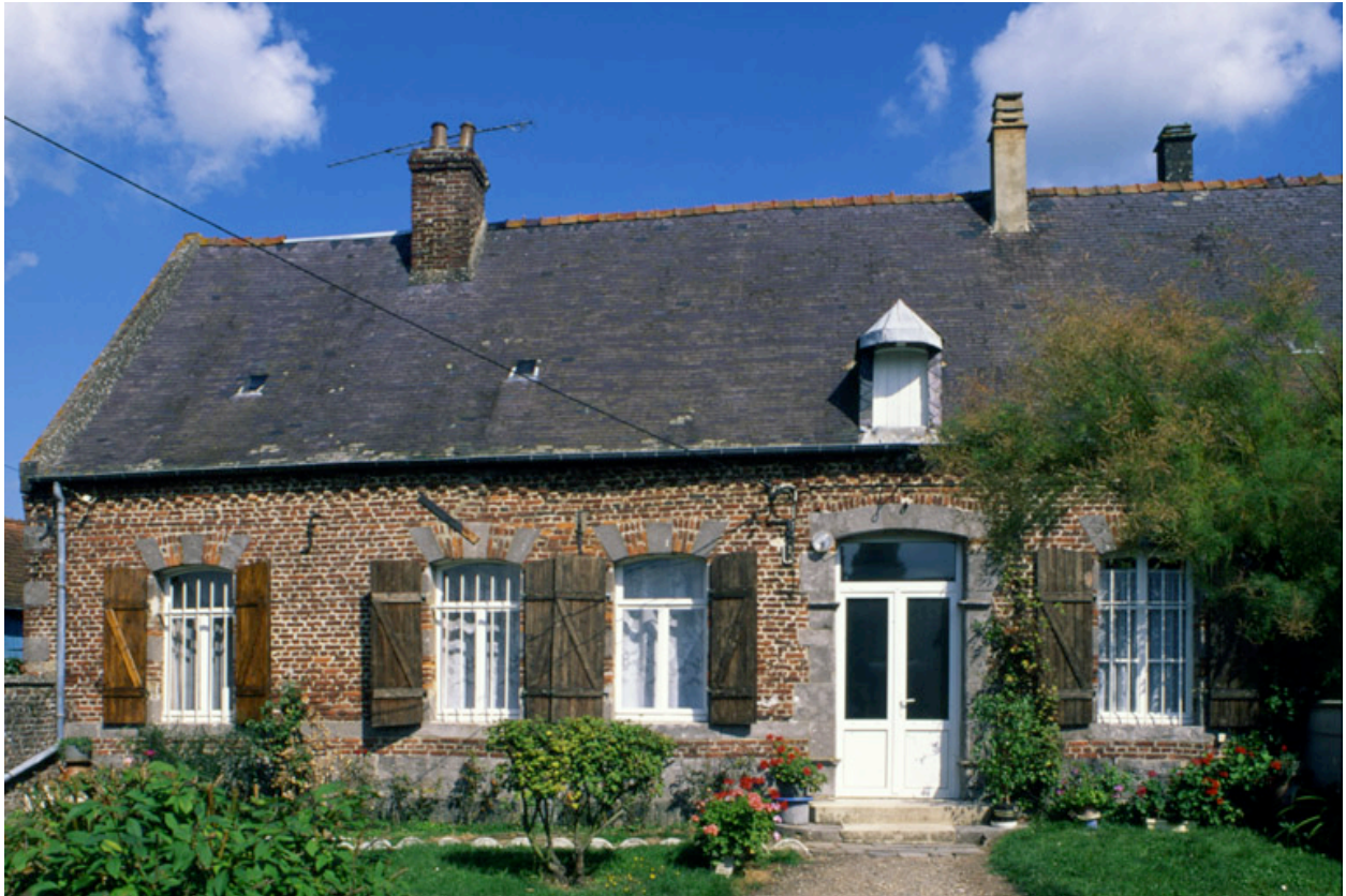
Vue partielle de la façade antérieure.
