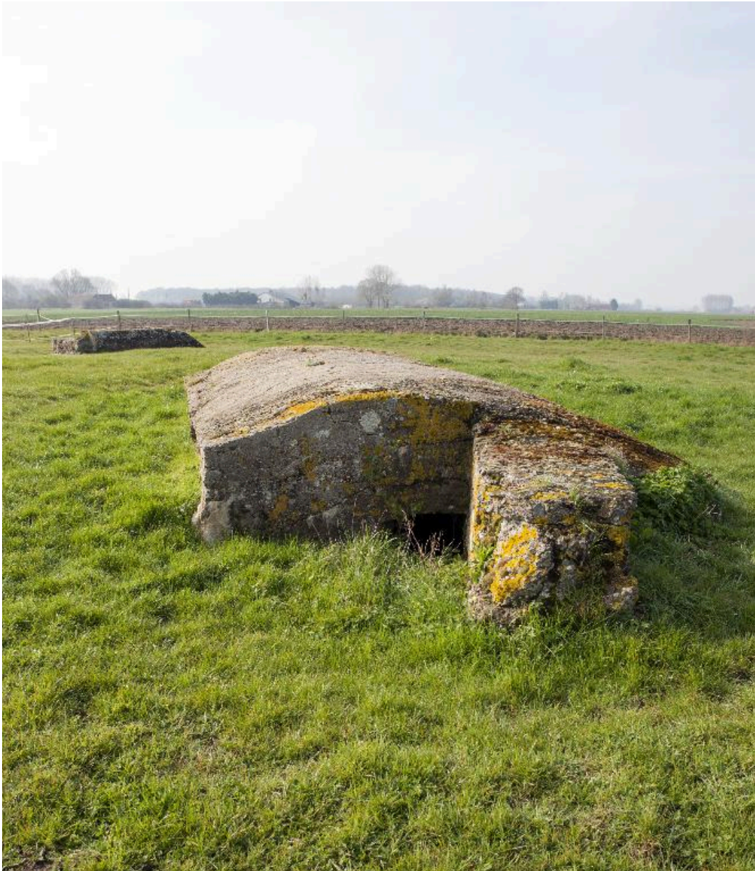
Vue des deux casemates, vers le sud. Au premier plan, l'entrée nord et son mur pare-souffle
