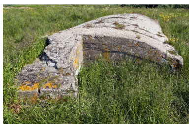
Casemate nord, entrée sud et son mur pare-souffle Phot. Jean-Marc Ramette IVR31_20145904351NUCA
