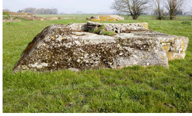
Casemate sud, vers le nord-ouest Phot. Pierre Thibaut IVR32_20165900578NUCA
