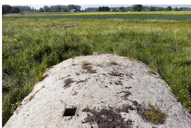
Casemate nord. Cheminée à périscope depuis l'extrados de voûte Phot. Jean-Marc Ramette IVR31_20145904353NUCA
