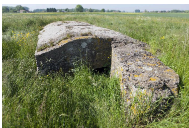
Casemate nord, entrée nord Phot. Jean-Marc Ramette IVR31_20145904350NUCA
