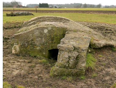
Vue des deux casemates, vers le sud. Au premier plan, l'entrée nord et son mur pare-souffle Phot. Jean-Marc Ramette IVR31_20145904357NUCA
