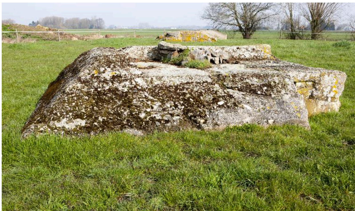
Casemate sud, vers le nord-ouest
