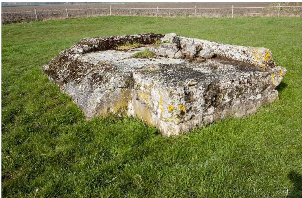
Casemate sud, vers le sud-ouest
