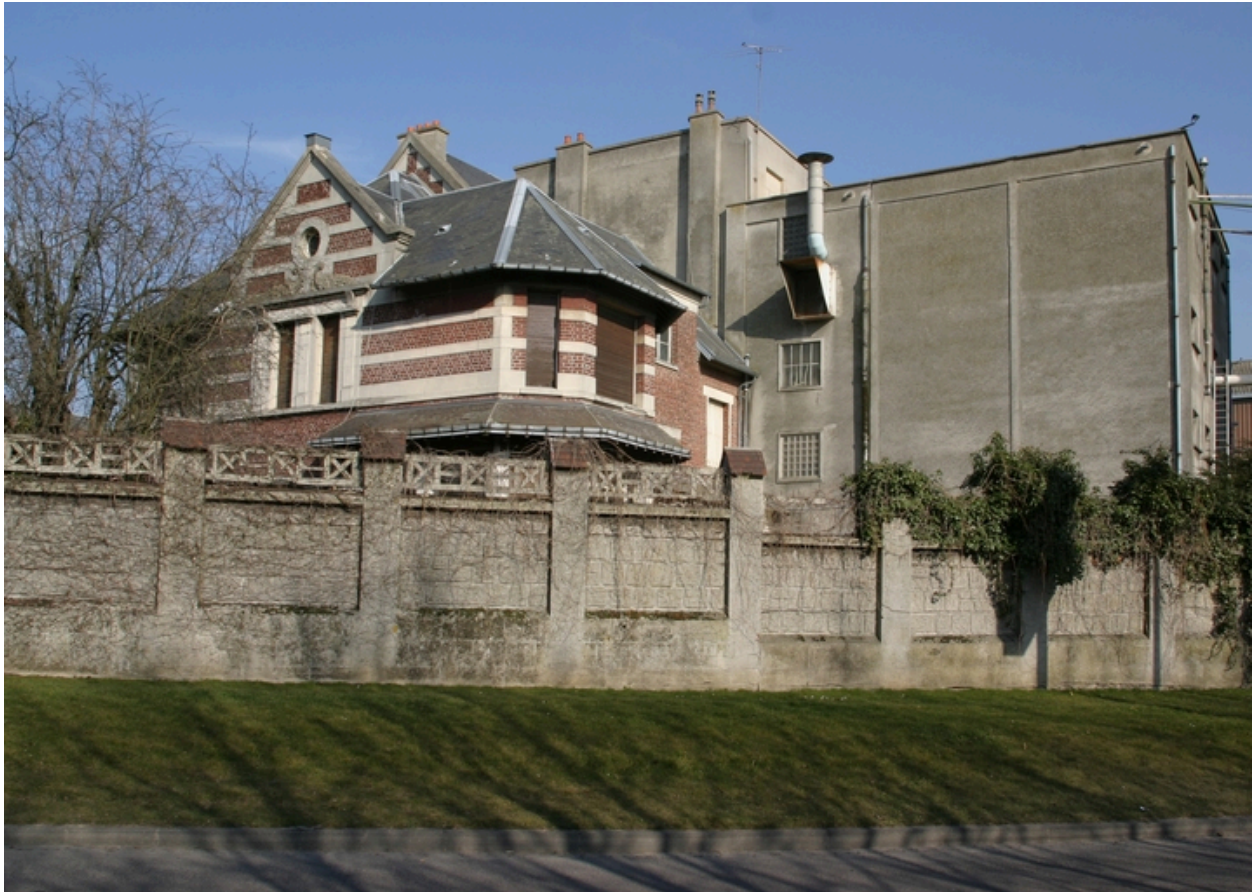
Logement patronal et silo à blé.
