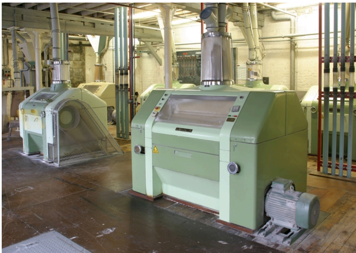
Premier étage de la minoterie : appareils à cylindres Golfetto.
