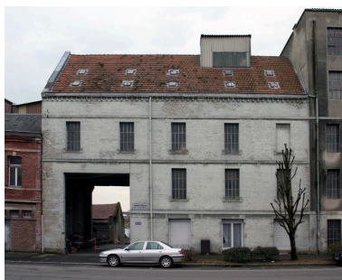
Façade antérieure de l'ancienne minoterie. Phot. Frédéric Pillet IVR22_20050205176NUCA
