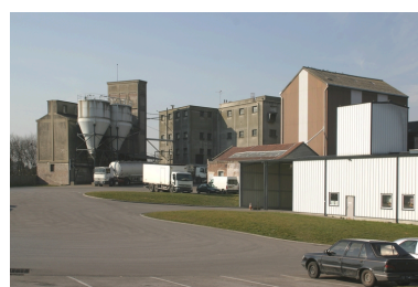
Le site de la minoterie vu depuis la rue Delavenne. Phot. Frédéric Pillet IVR22_20050205174NUCA
