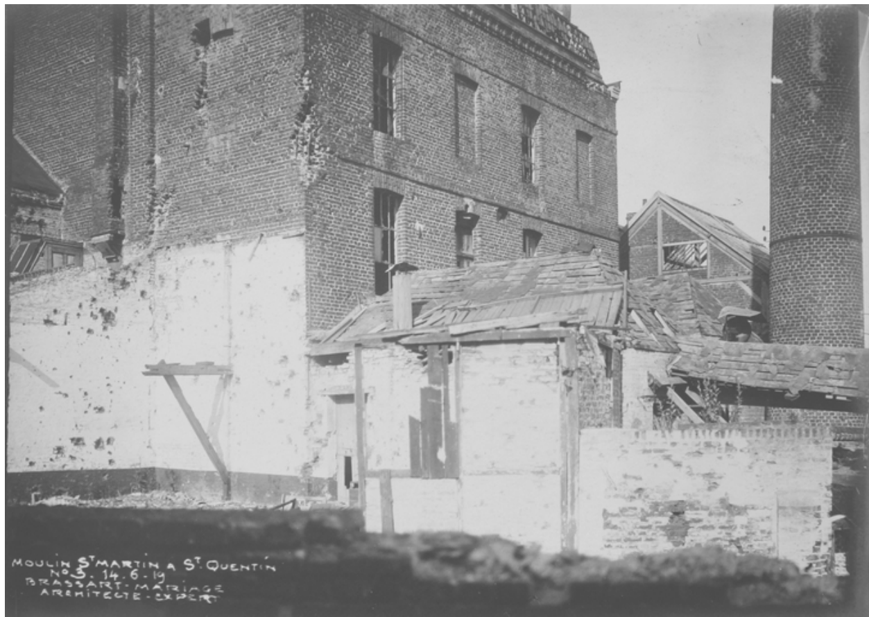
Façade postérieure de la minoterie, en juin 1919 (AD Aisne).
