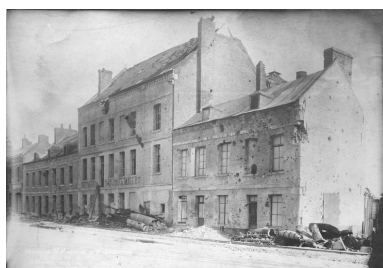
Façade antérieure de la minoterie en juin 1919, boulevard Victor-Hugo (AD Aisne). Phot. Pillet Frédéric IVR22_20050205165NUCAB
