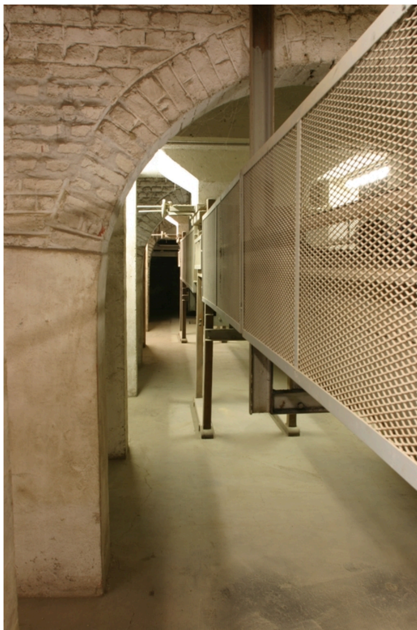
Base des cellules du silo à blé.
