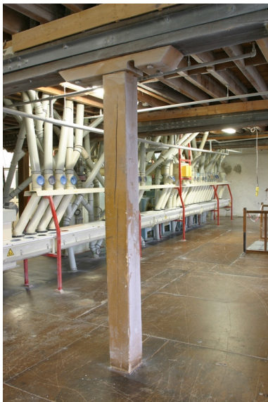
Troisième étage de la minoterie. Phot. Frédéric Pillet IVR22_20050205181NUCA
