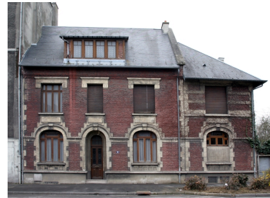
Façade antérieure du logement patronal de 1923. Phot. Frédéric Pillet IVR22_20050205189NUCA
