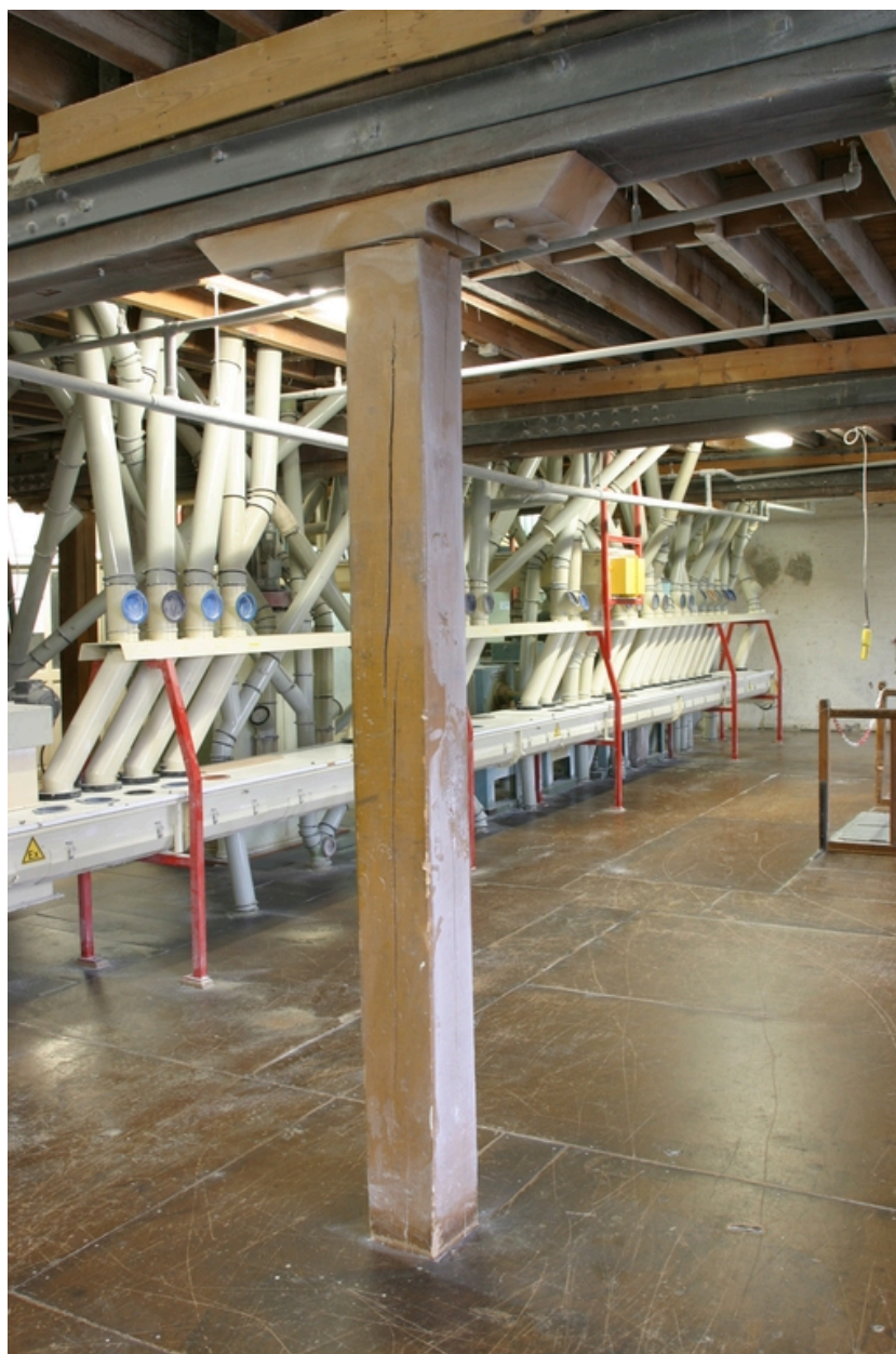
Troisième étage de la minoterie.
