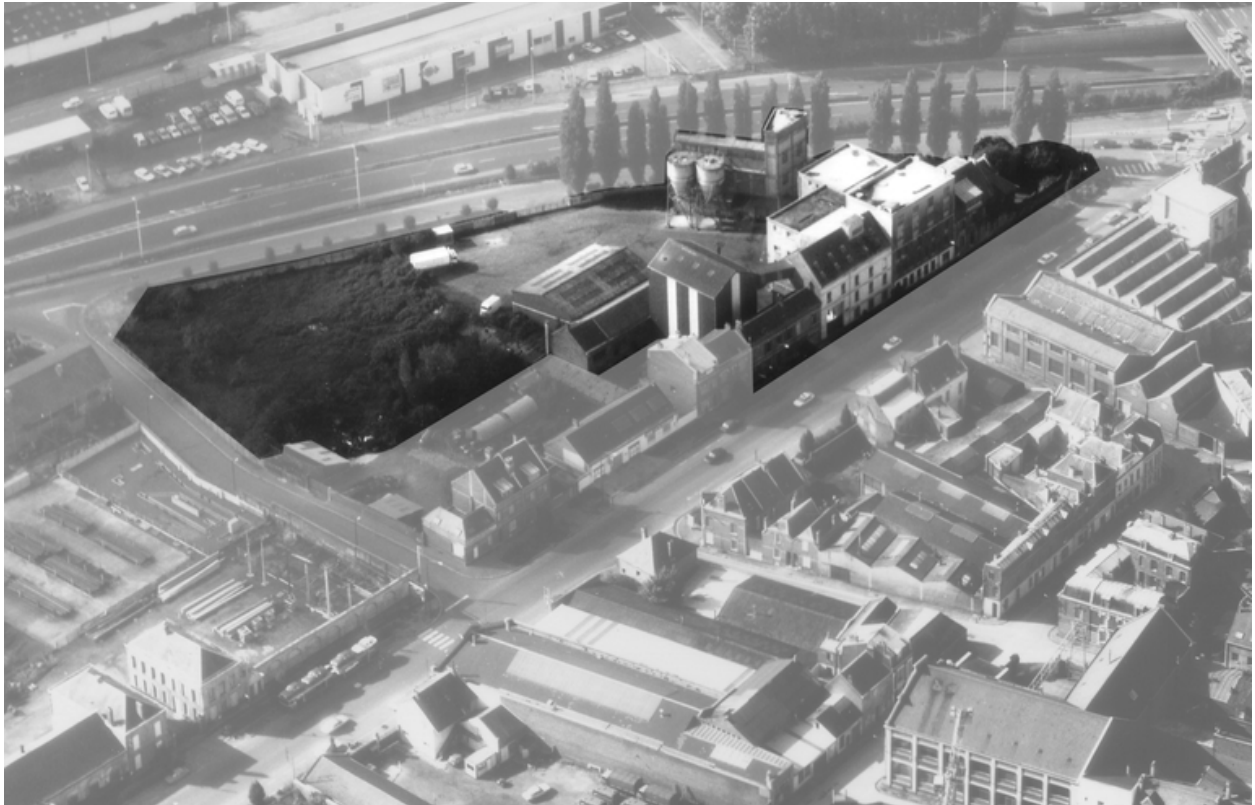
Vue aérienne de la minoterie en 1989.
