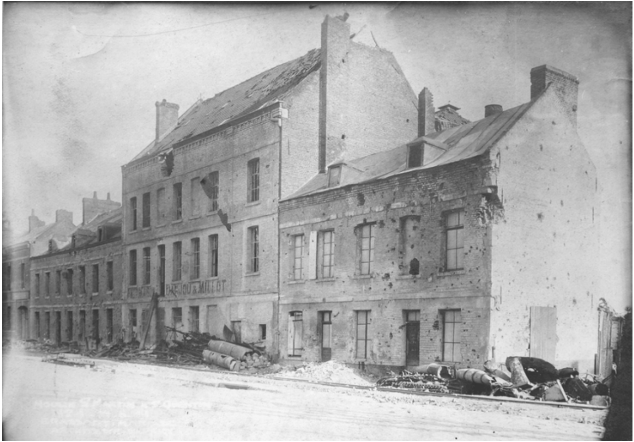
Façade antérieure de la minoterie en juin 1919, boulevard Victor-Hugo (AD Aisne).
