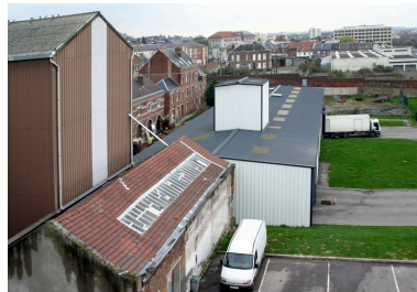
Au premier plan le silo à farine et l'ancienne chaufferie. A l'arrière plan, le magasin de stockage construit en 2000. Phot. Frédéric Pillet IVR22_20050205188NUCA
