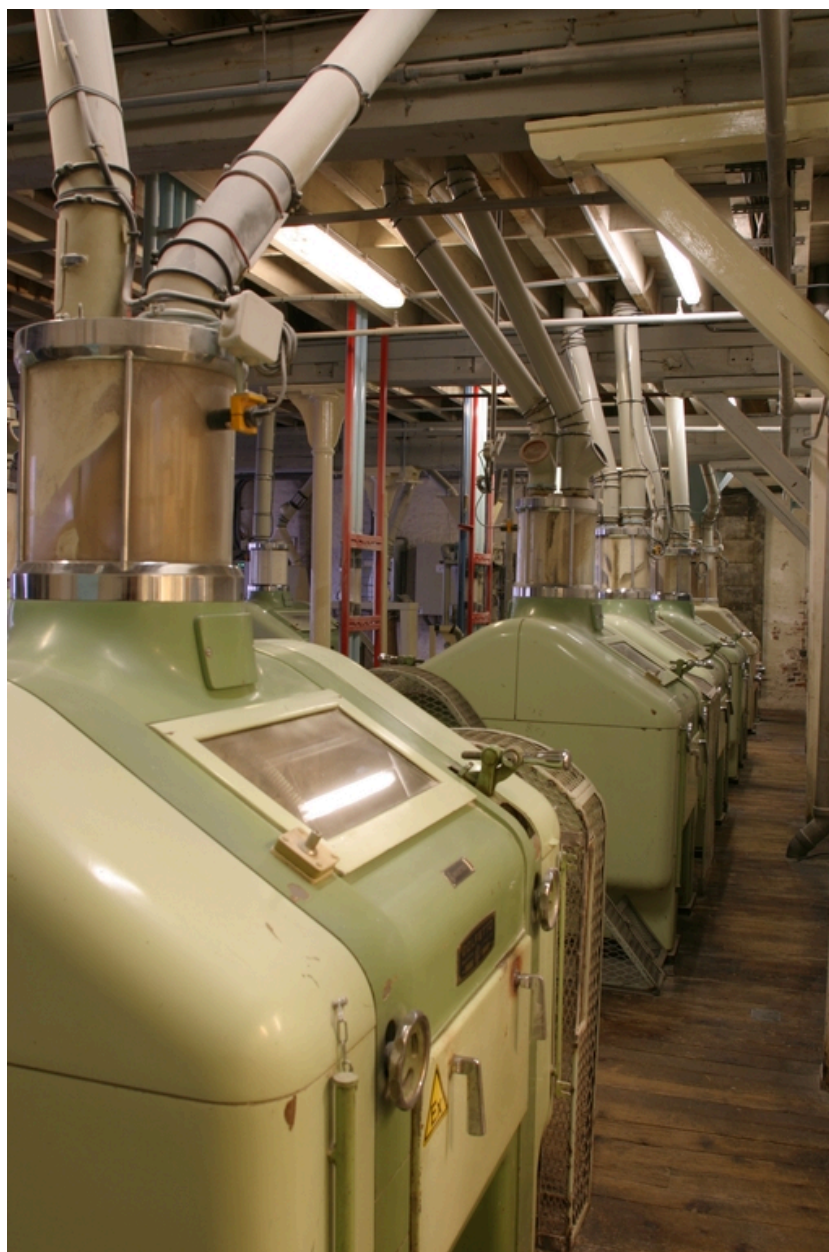
Premier étage de la minoterie : appareils à cylindres Golffetto.
