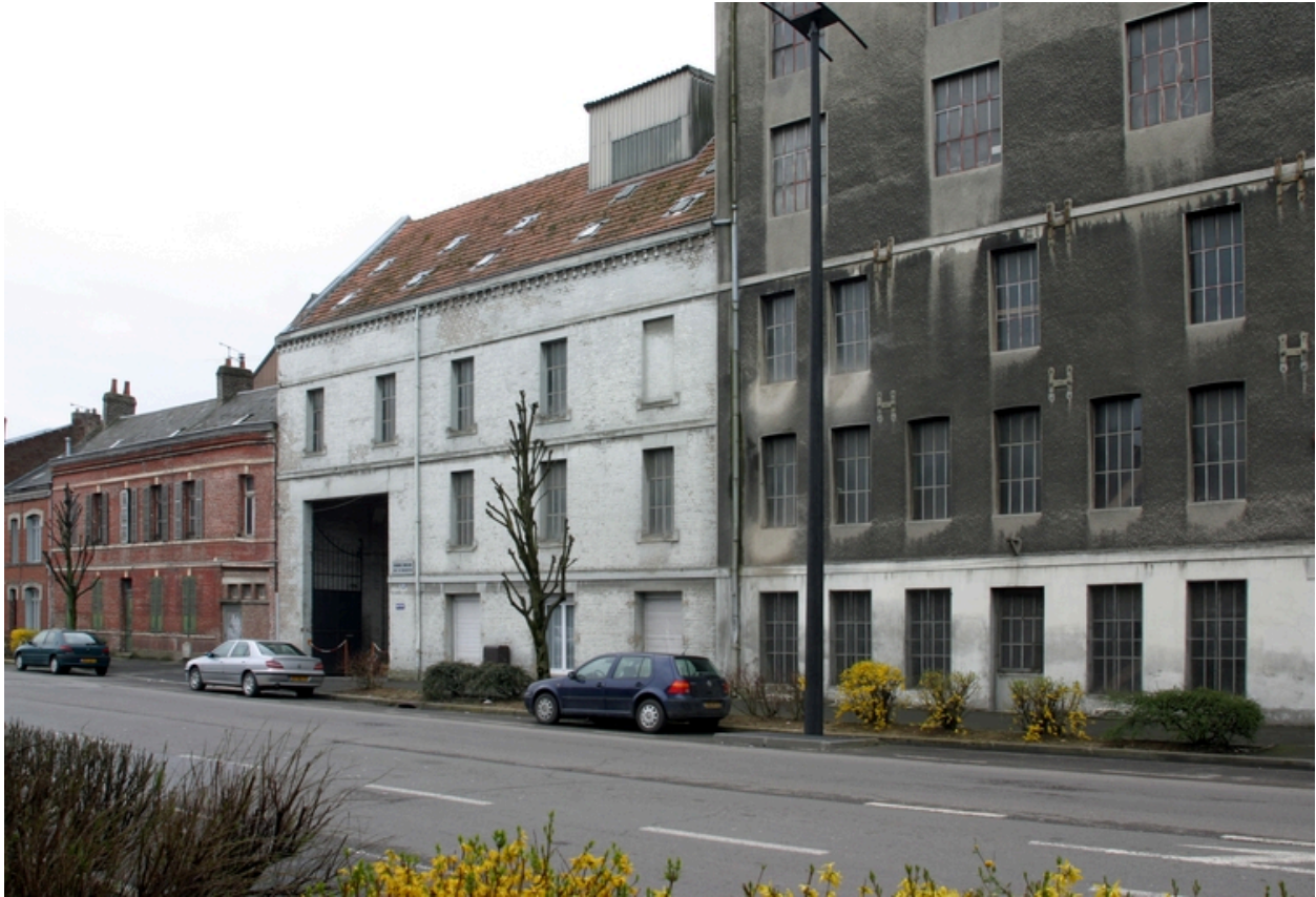
Façades antérieures des anciennes habitations et minoterie (à gauche) et de l'actuel bâtiment de production (à droite).
