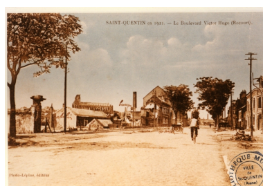
A gauche, le site de la minoterie photographié par Lépine depuis le boulevard Victor-Hugo, vers 1919 (BM Saint-Quentin). Phot. Pillet Frédéric IVR22_20050205170NUCAB
