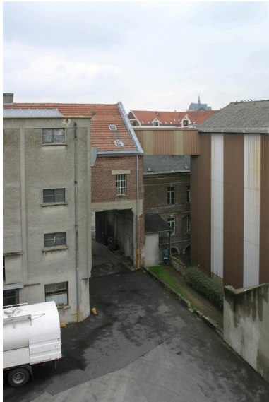
De gauche à droite : actuelle minoterie (en béton) et ancienne minoterie (porche), habitation et silo à farine (en tôle, à droite). Phot. Frédéric Pillet IVR22_20050205178NUCA
