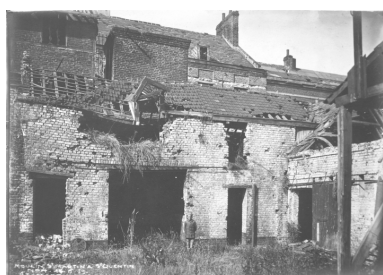
Chaufferie (premier plan), salle des machines et minoterie (toiture à l'arrière plan) photographiées depuis la cour intérieure en juin 1919 (AD Aisne). Phot. Pillet Frédéric IVR22_20050205168NUCAB
