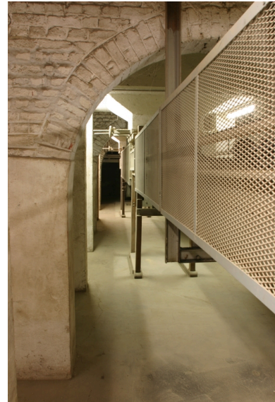
Base des cellules du silo à blé. Phot. Frédéric Pillet IVR22_20050205186NUCA
