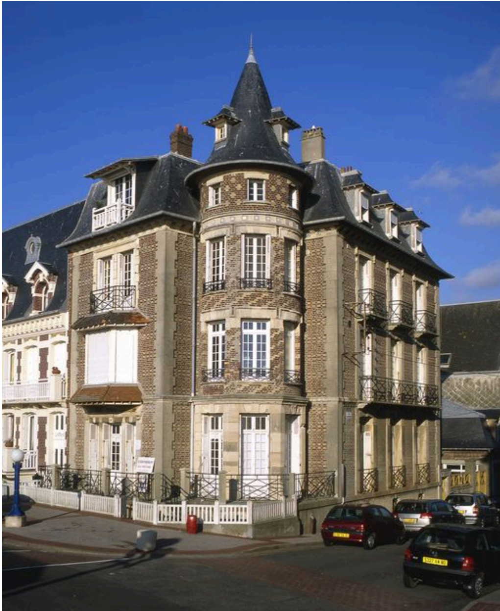
Vue d'ensemble depuis l'esplanade.
