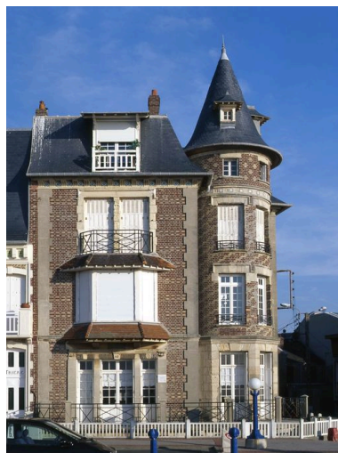
Elévation antérieure coté mer. Phot. Marie-Laure Monnehay-Vulliet IVR22_20048000297XA
