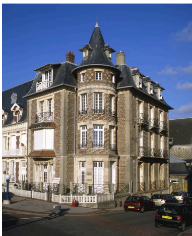
Vue d'ensemble depuis l'esplanade. Phot. Marie-Laure Monnehay-Vulliet IVR22_20048000298XA
