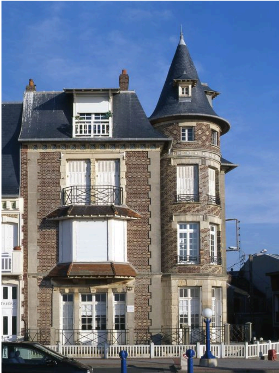
Elévation antérieure coté mer.
