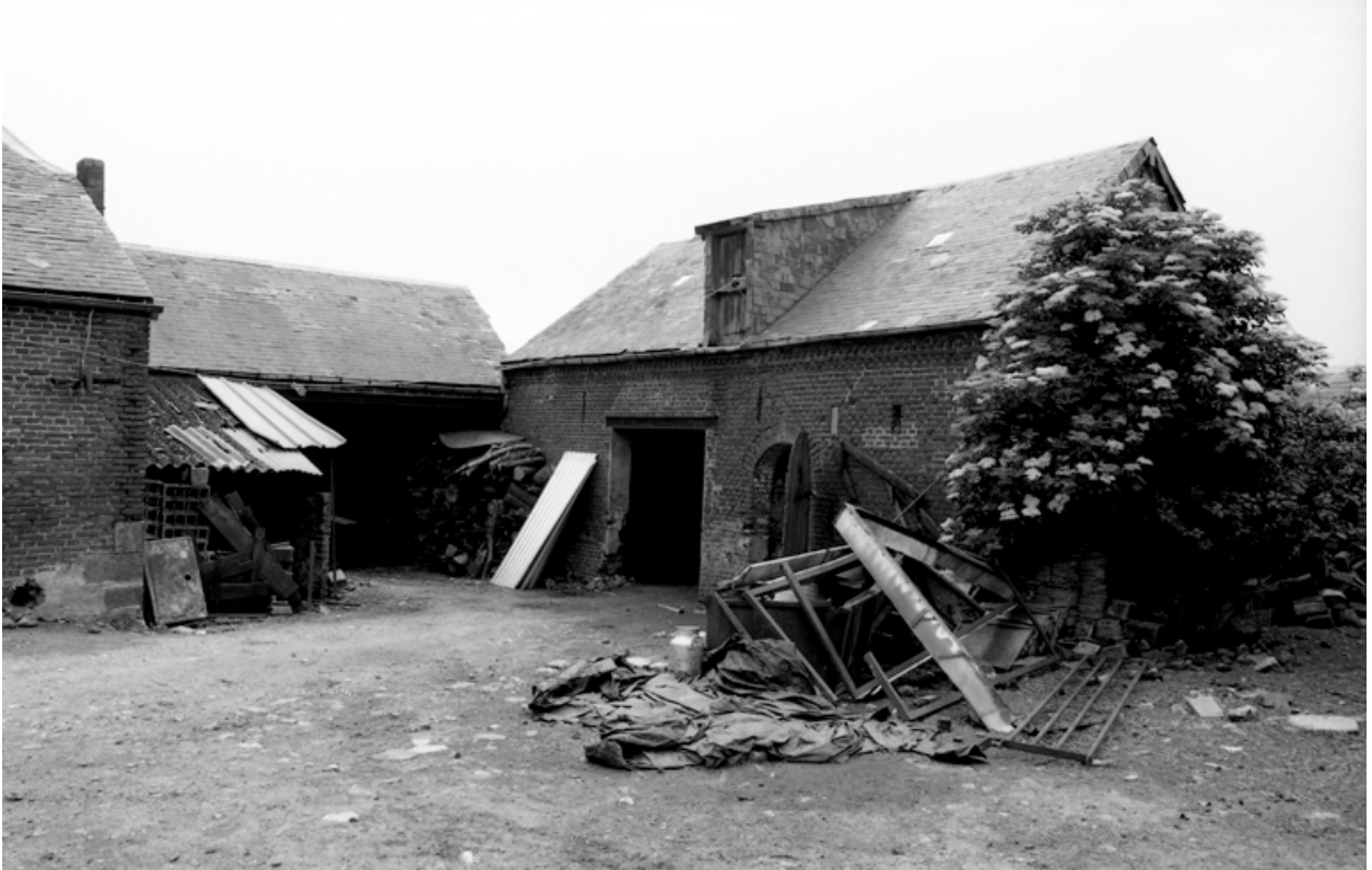
Elévation sur cour de l'étable ouest.
