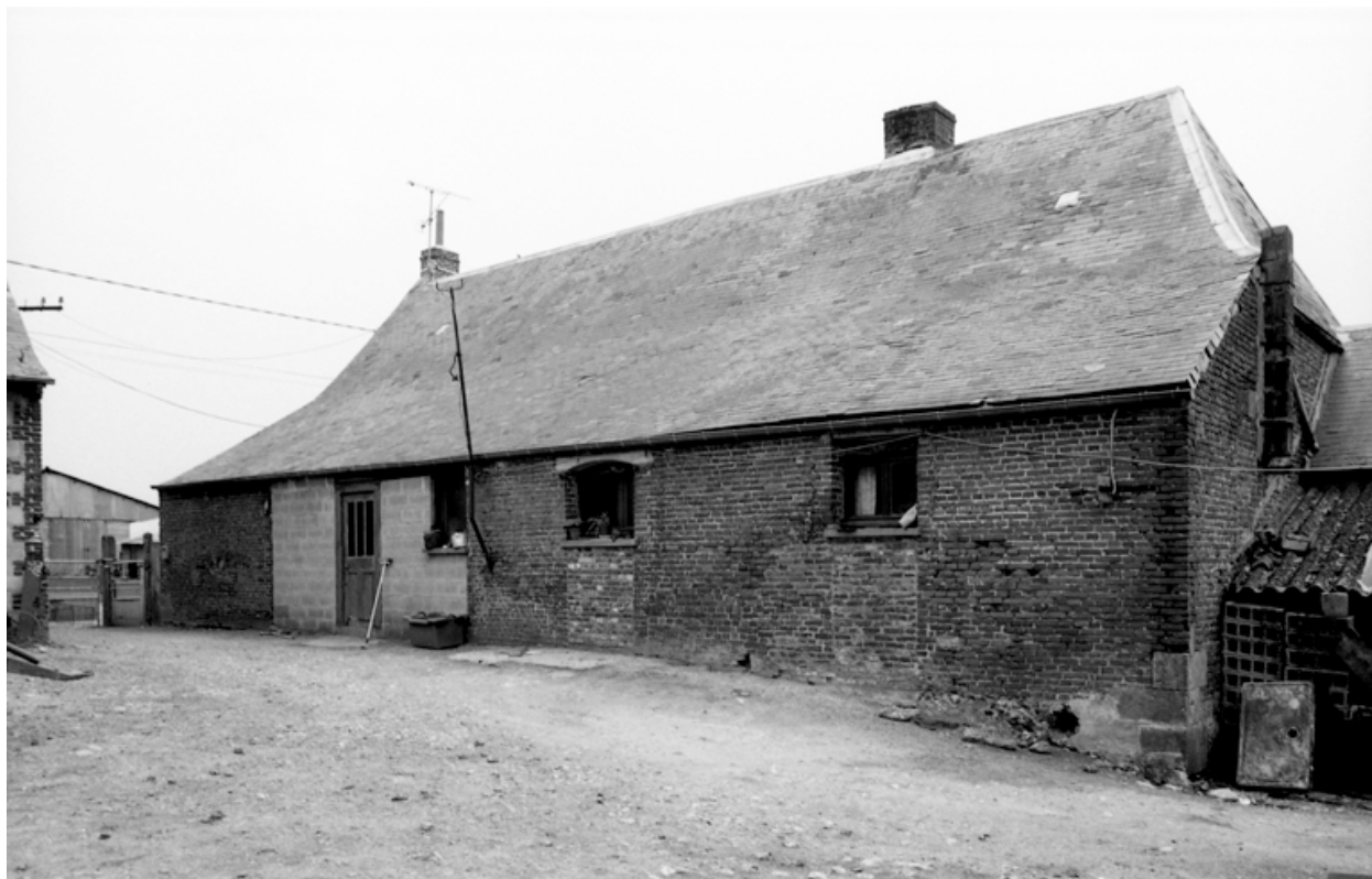
Elévation arrière du logis.
