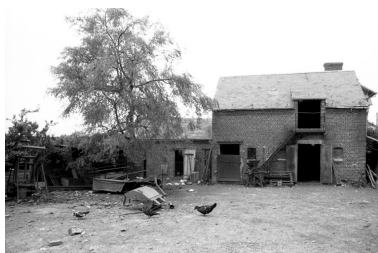
Elévation sur cour de l'étable nord. Phot. Thierry Lefébure IVR22_19920201074Z
