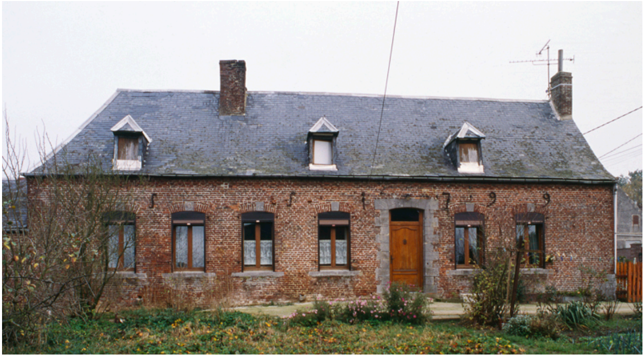
Vue de la façade du logis, portant la date de 1799.
