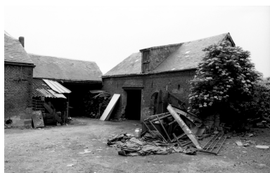
Elévation sur cour de l'étable ouest. Phot. Thierry Lefébure IVR22_19920201070Z
