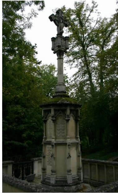
Vue rapprochée du monument (face postérieure). Phot. Caroline Vincent IVR22_20068001828NUCA
