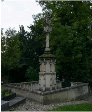
Vue générale (face postérieure). Phot. Caroline Vincent IVR22_20068001827NUCA
