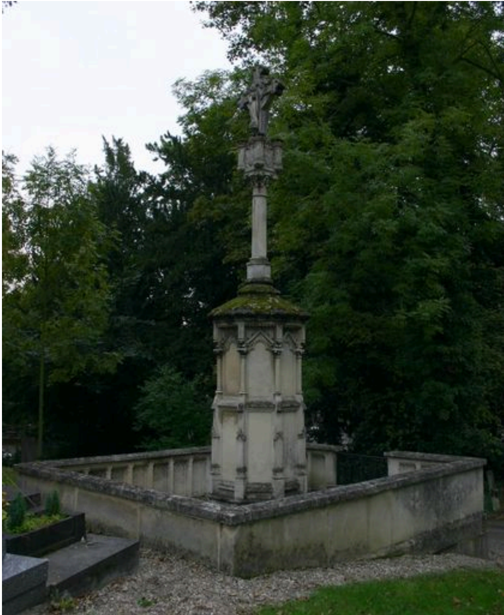
Vue générale (face postérieure).
