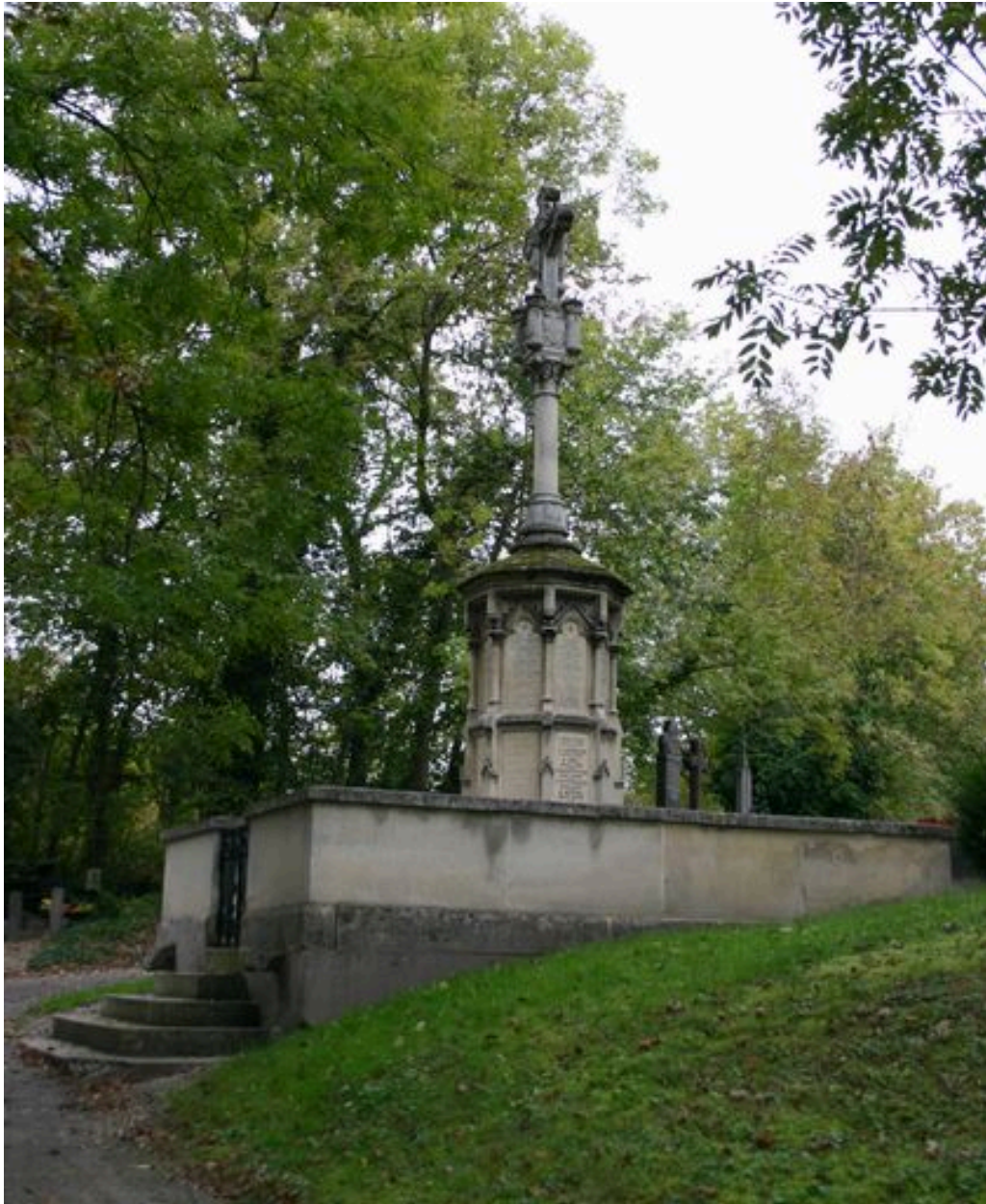
Vue générale latérale.
