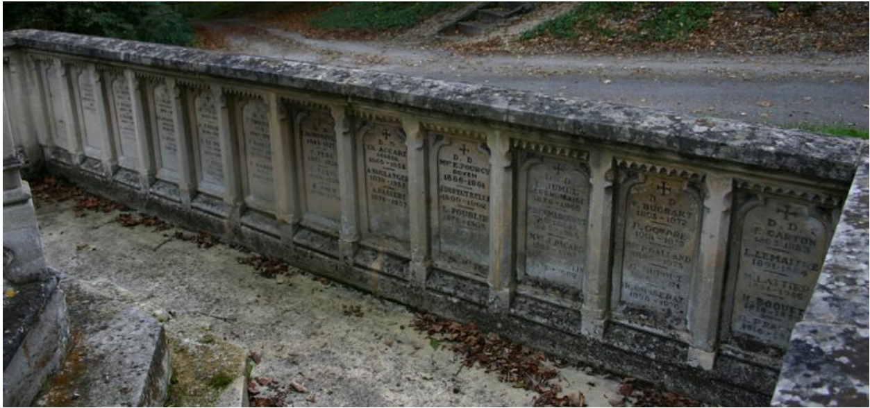
Détail du mur-pâlis intérieur.
