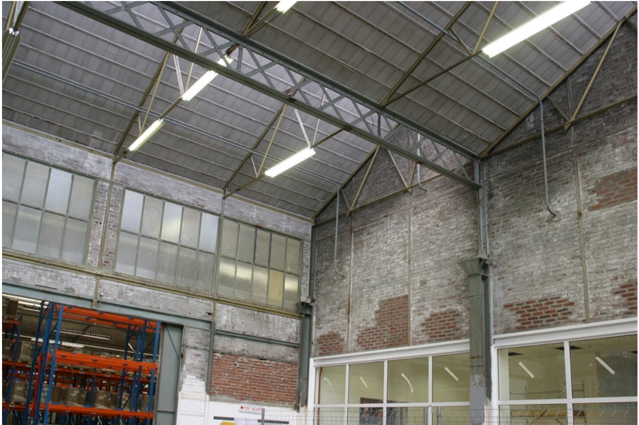
Vue intérieure des ateliers de 1962-1963 en cours de transformation.
