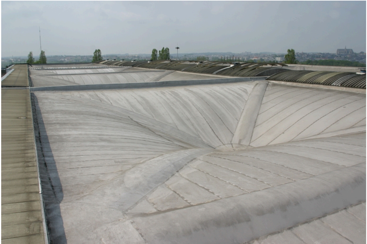
Toiture des ateliers de 1967.
