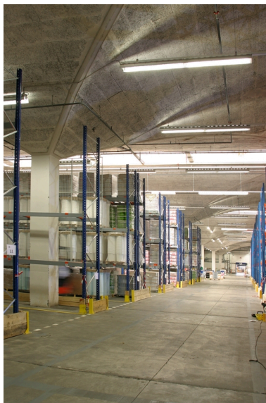
Entrepôt industriel de 1966. Phot. Frédéric Pillet IVR22_20060205285NUCA
