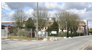
Vue générale de l'usine depuis l'entrée du site.
