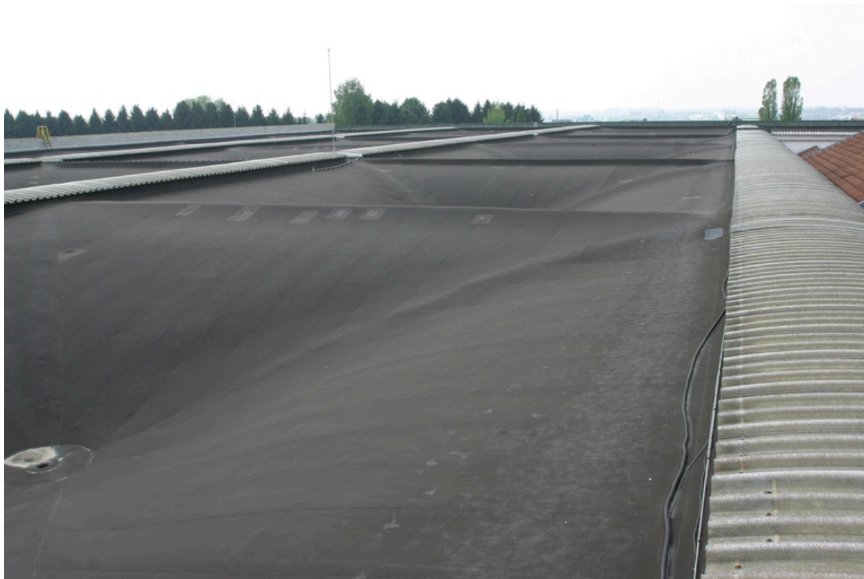
Toiture des entrepôts et magasins de 1966.
