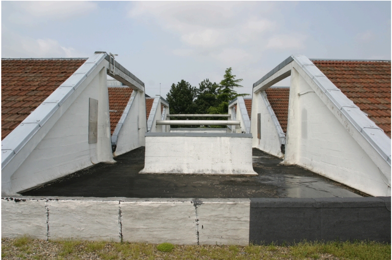
Détail des sheds des ateliers de 1929.
