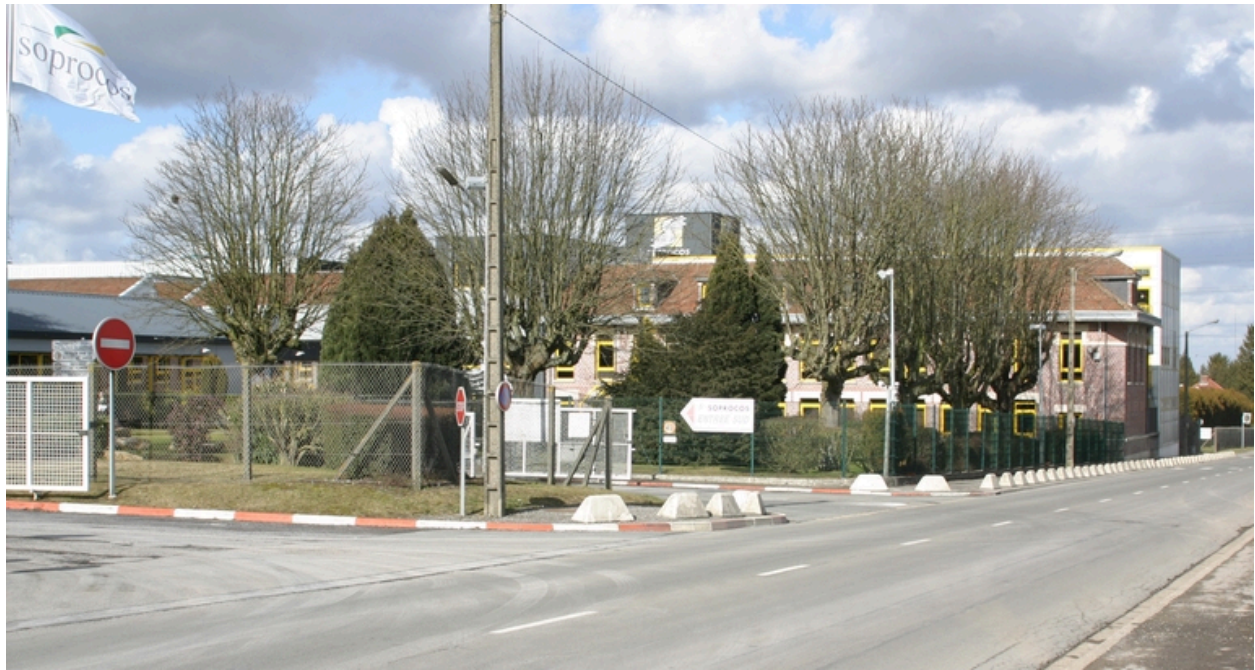
Vue générale de l'usine depuis l'entrée du site.
