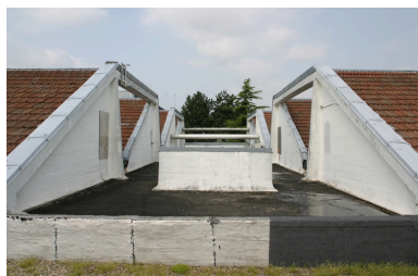
Détail des sheds des ateliers de 1929.
