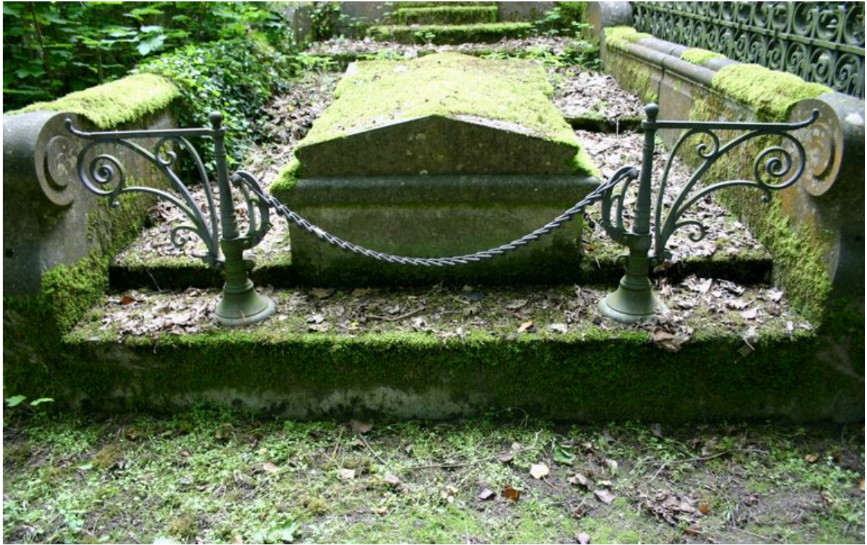
Détail de la clôture antérieure.
