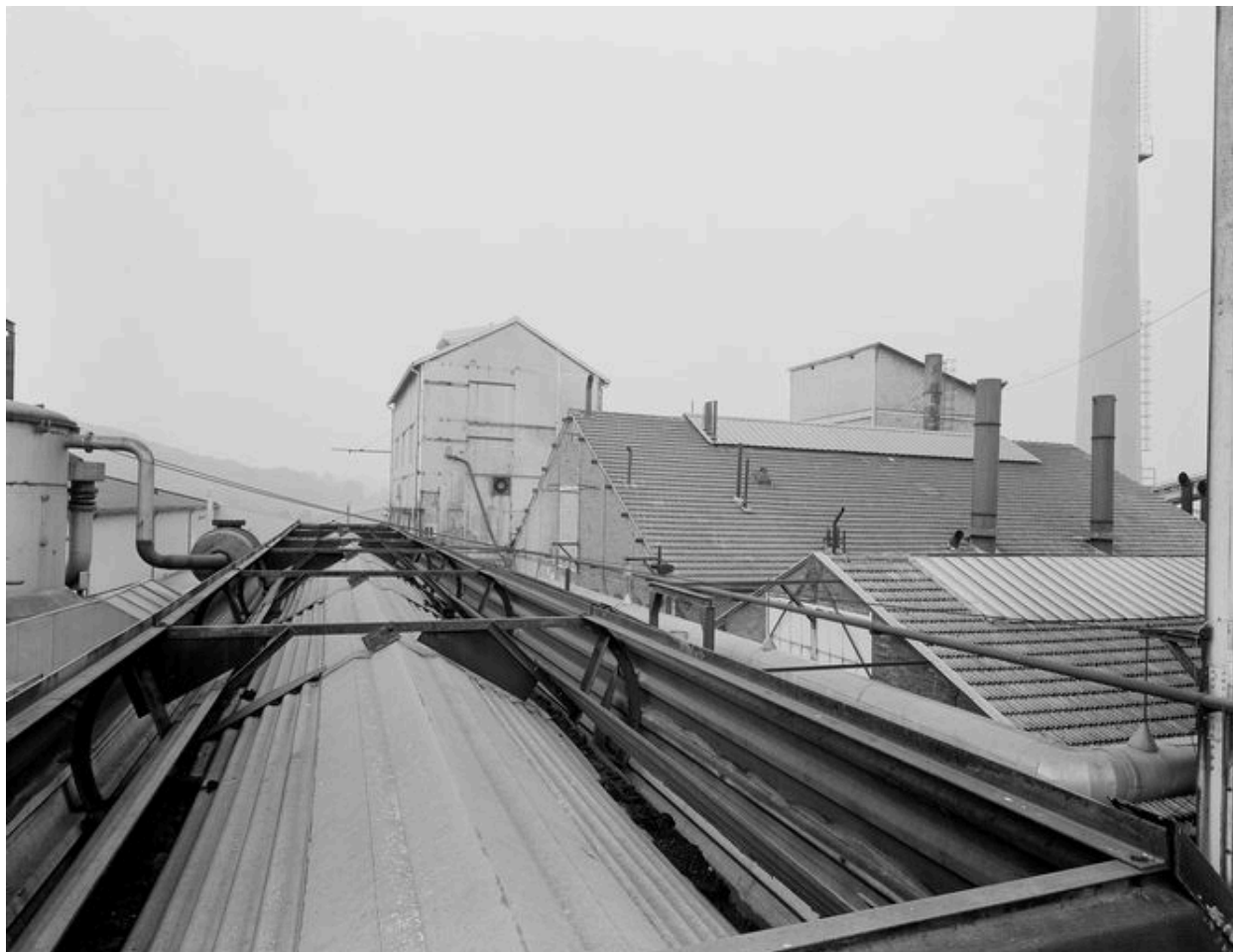
Vue générale des chaufferies (toitures).
