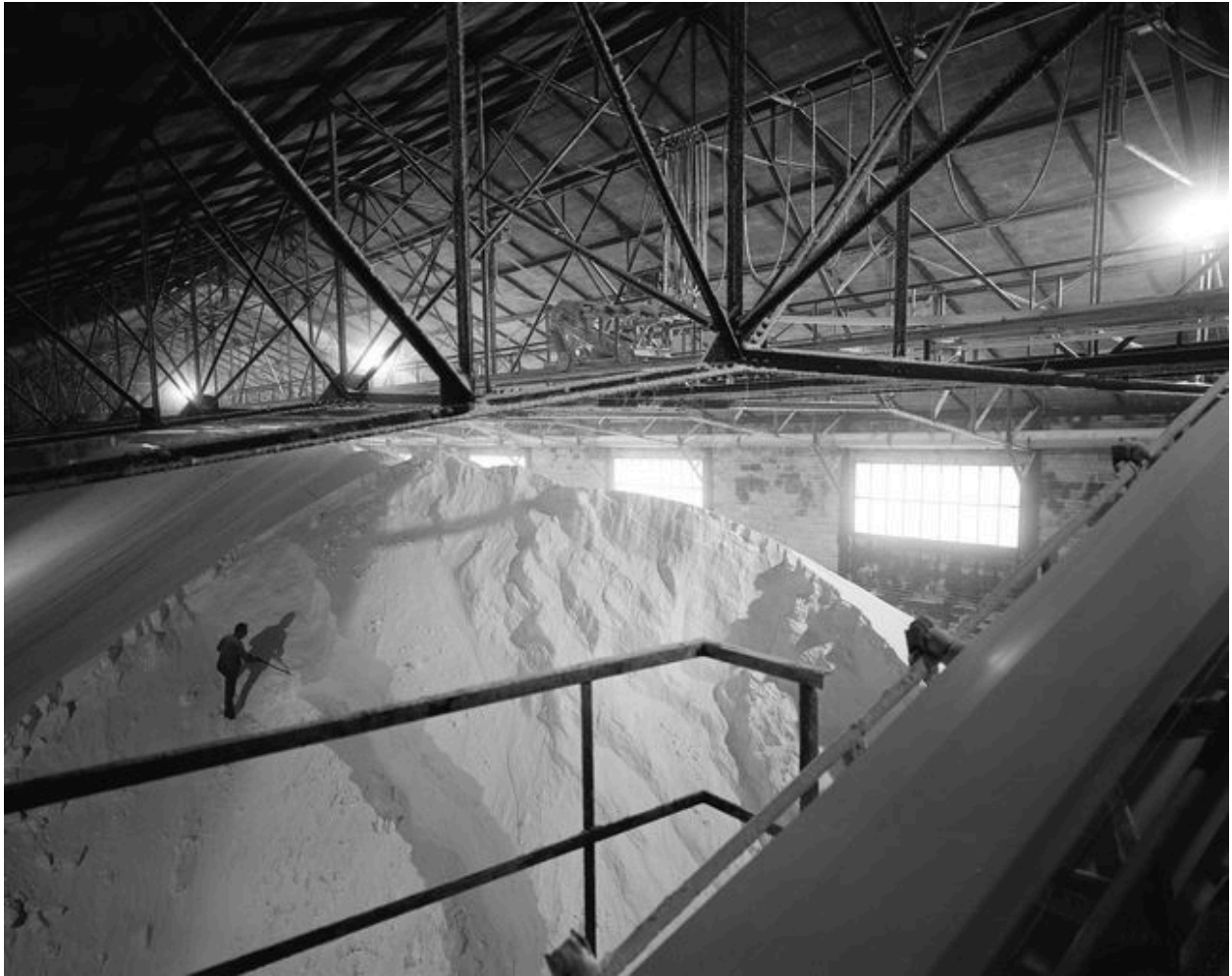
Magasin industriel : vue intérieure.
