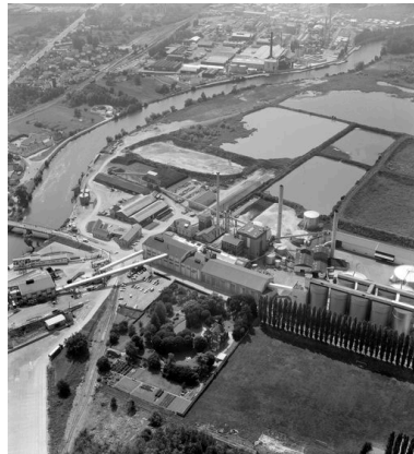
Vue aérienne du site, en 1991. Phot. Phot'R IVR22_19916000254P
