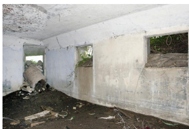
Intérieur de l'édifice vers le nord-est Phot. Pierre Thibaut IVR31_20155900620NUCA
