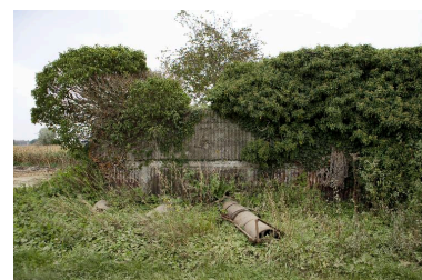
Élévation ouest, détail Phot. Jean-Marc Ramette IVR31_20145905474NUCA
