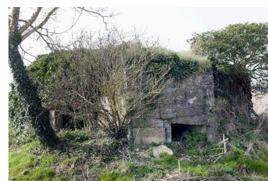
Vue de trois-quarts vers le sud-ouest Phot. Pierre Thibaut IVR31_20155900626NUCA
