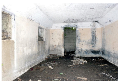
Intérieur de l'édifice depuis l'entrée nord Phot. Pierre Thibaut IVR31_20155900622NUCA
