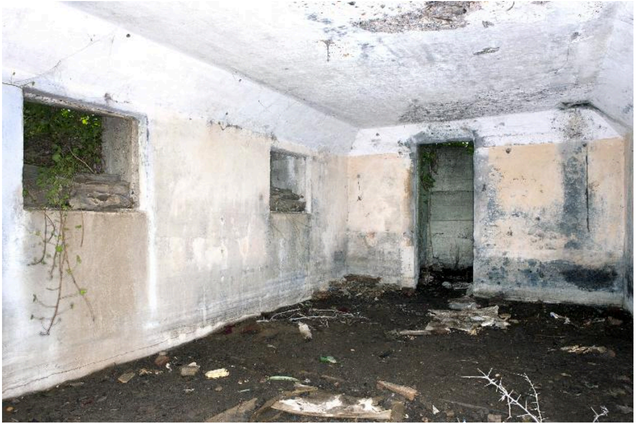
Intérieur de l'édifice vers l'entrée sud
