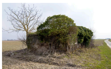
Vue de trois-quarts vers le sud-est Phot. Jean-Marc Ramette IVR31_20145905469NUCA
