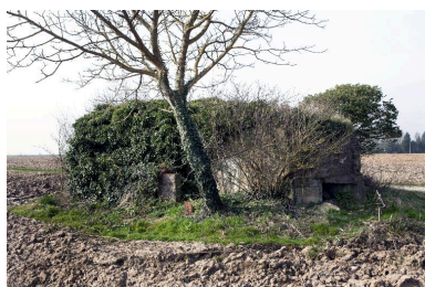
Elévaton est Phot. Pierre Thibaut IVR31_20155900625NUCA
