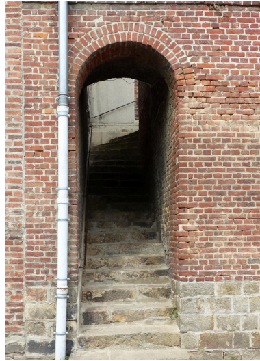
Passage et escalier reliant la rue Fournier à la rue du Collège. Phot. Isabelle Barbedor IVR32_20228005112NUCA
