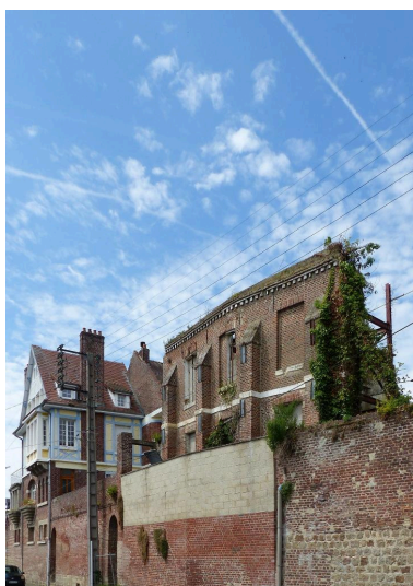
Les demeures de la rue Fournier vues depuis la rue du Collège. Au premier plan, la maison du n°9, partiellement écroulée en 1893. Phot. Isabelle Barbedor IVR32_20228005111NUCA
