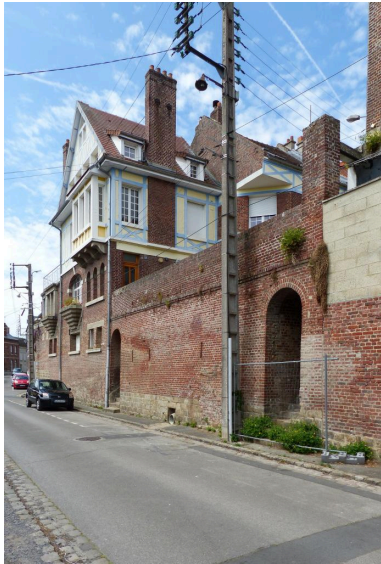
Demeure, 16 rue Fournier, reconstruite vers 1930. Vue depuis la rue du Collège. Phot. Isabelle Barbedor IVR32_20228005114NUCA
