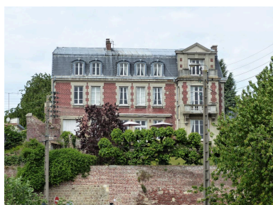
Ancien hôtel Dehaussy de Maigremont. Vue depuis la rue du Collège. Phot. Isabelle Barbedor IVR32_20228005162NUCA
