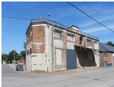
Vue d'ensemble sur rue. Phot. Bertrand Fournier IVR22_20158005912NUCA
