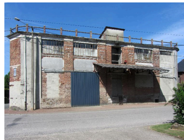
Façade sur rue du moulin. Phot. Bertrand Fournier IVR22_20158005911NUCA
