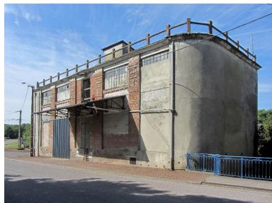
Vue d'ensemble sur rue et du pignon sur la rivière. Phot. Bertrand Fournier IVR22_20158005913NUCA
