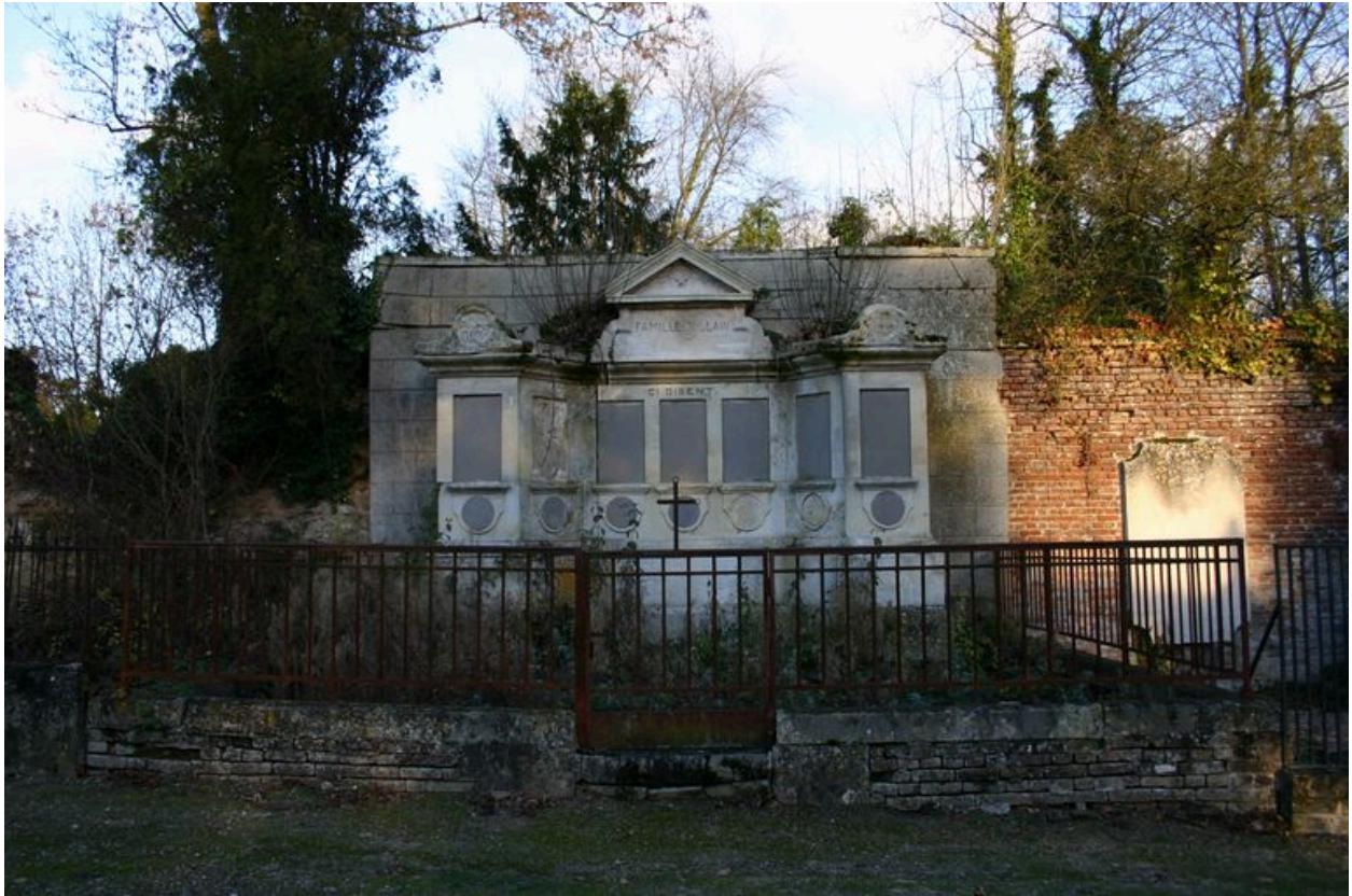
Vue générale, après les travaux de restauration (1er semestre 2009).
