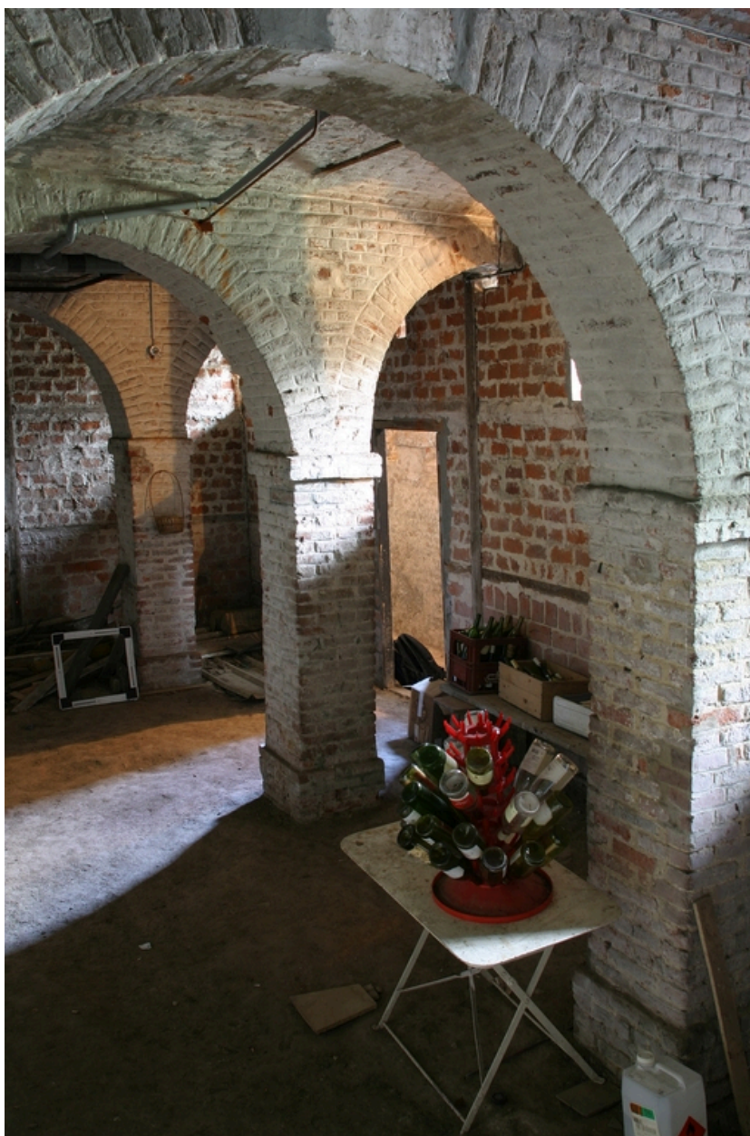
Vestiges du tissage, partie nord : sous-sol.
