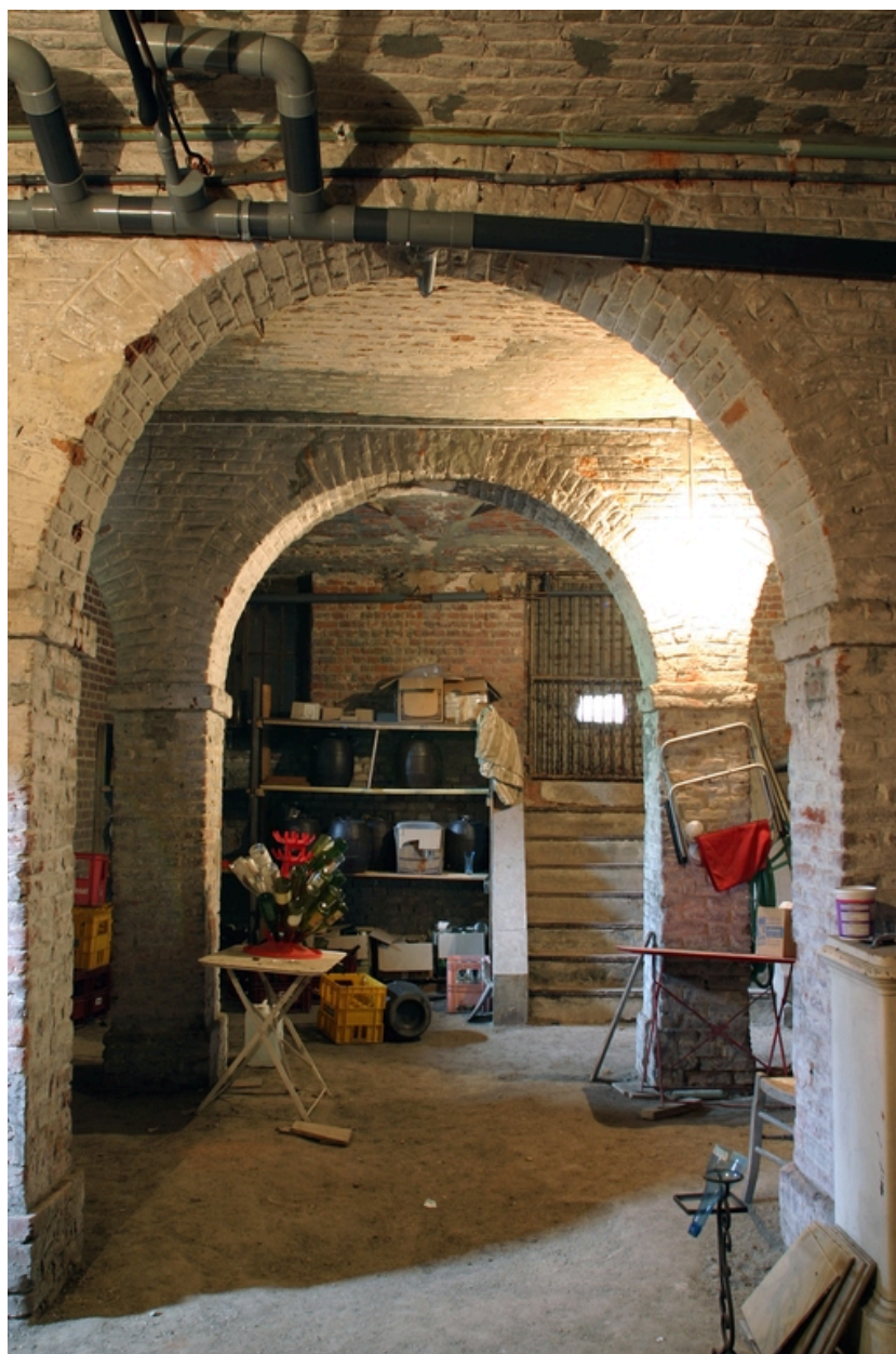
Vestiges du tissage, partie nord : sous-sol.
