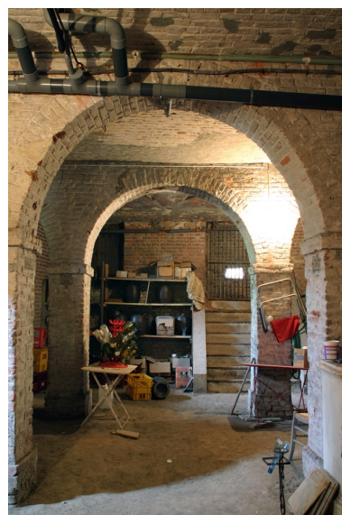
Vestiges du tissage, partie nord : sous-sol.
